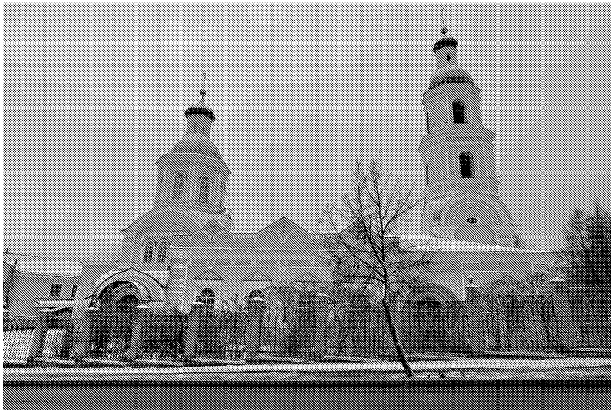
Вид на северный фасад здания вдоль ул. Чкалова (17.12.2021 г.)
