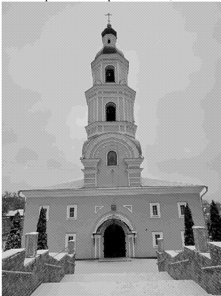
Вид на западный фасад здания (колокольню и притвор) (17.12.2021 г.)
