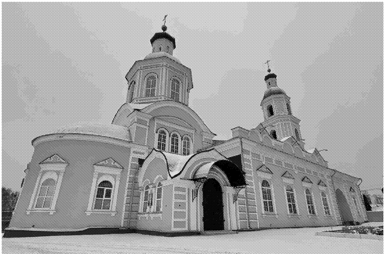
Вид на северо-восточный фасад здания (17.12.2021 г.)
