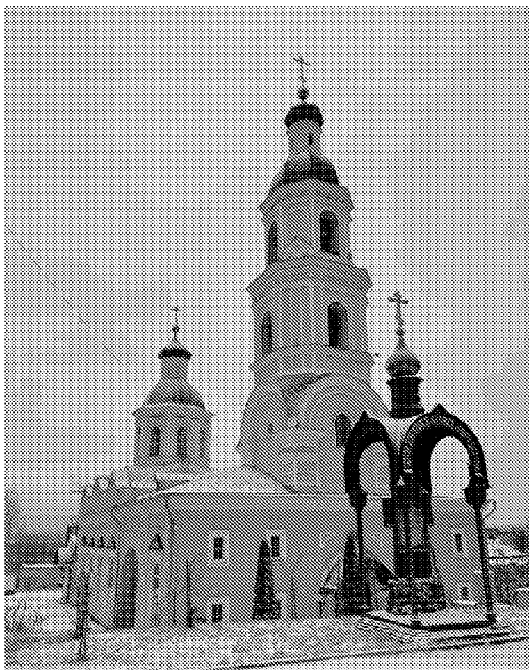
Вид на северо-западный фасад здания (17.12.2021 г.)
