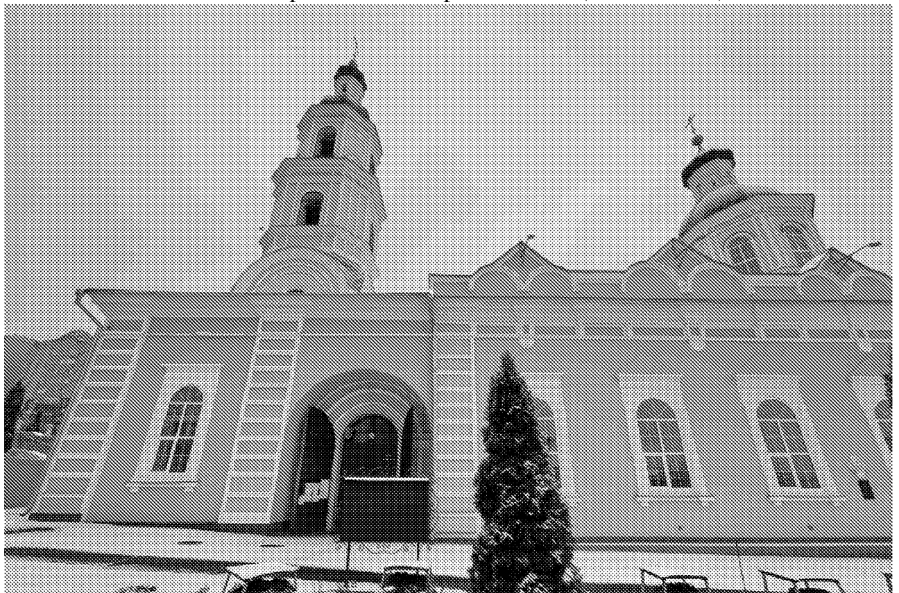
Вид на фрагмент южного фасада здания (17.12.2021 г.)
