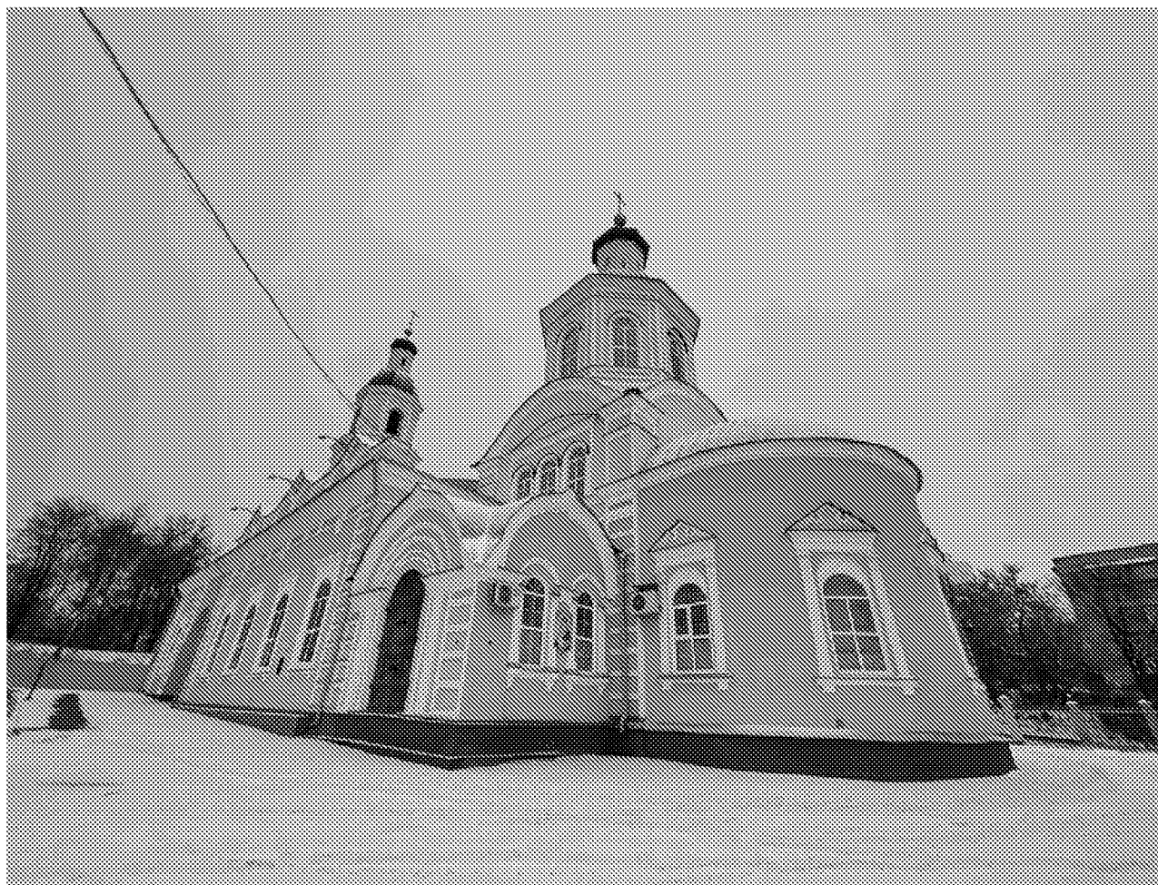
Вид на юго-восточный фасад здания (17.12.2021 г.)
