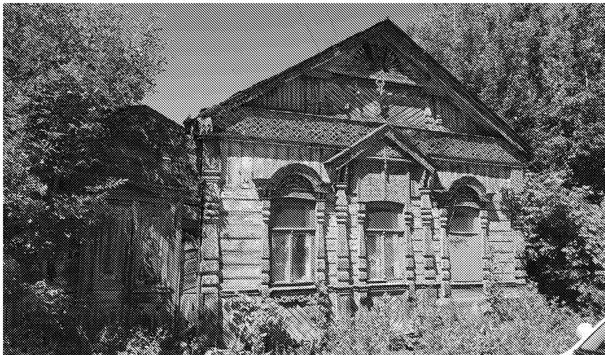
Вид на объект культурного наследия с восточной стороны (27.06.2022)
