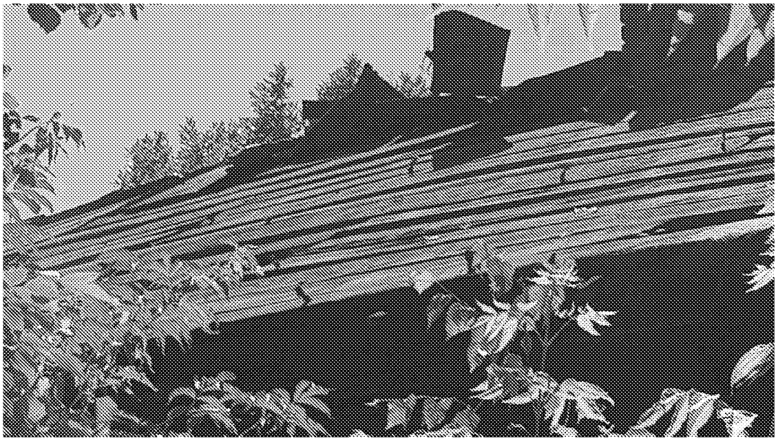
Вид на крышу объекта культурного наследия с северной стороны (27.06.2022)
