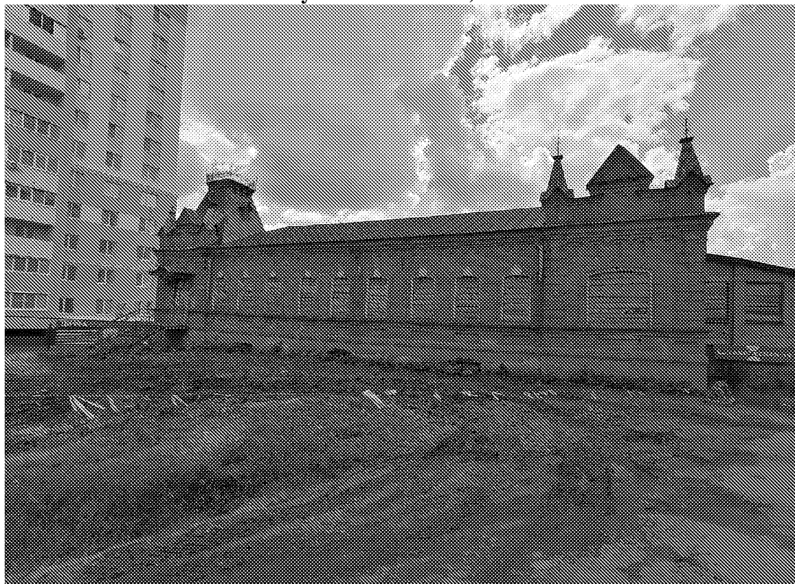
Общий вид на главный фасад объекта культурного наследия
