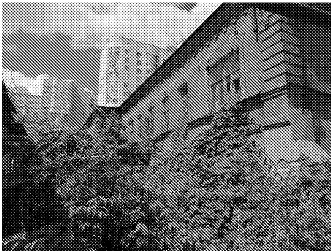
Вид с восточной стороны на дворový фасад объекта культурного наследия
