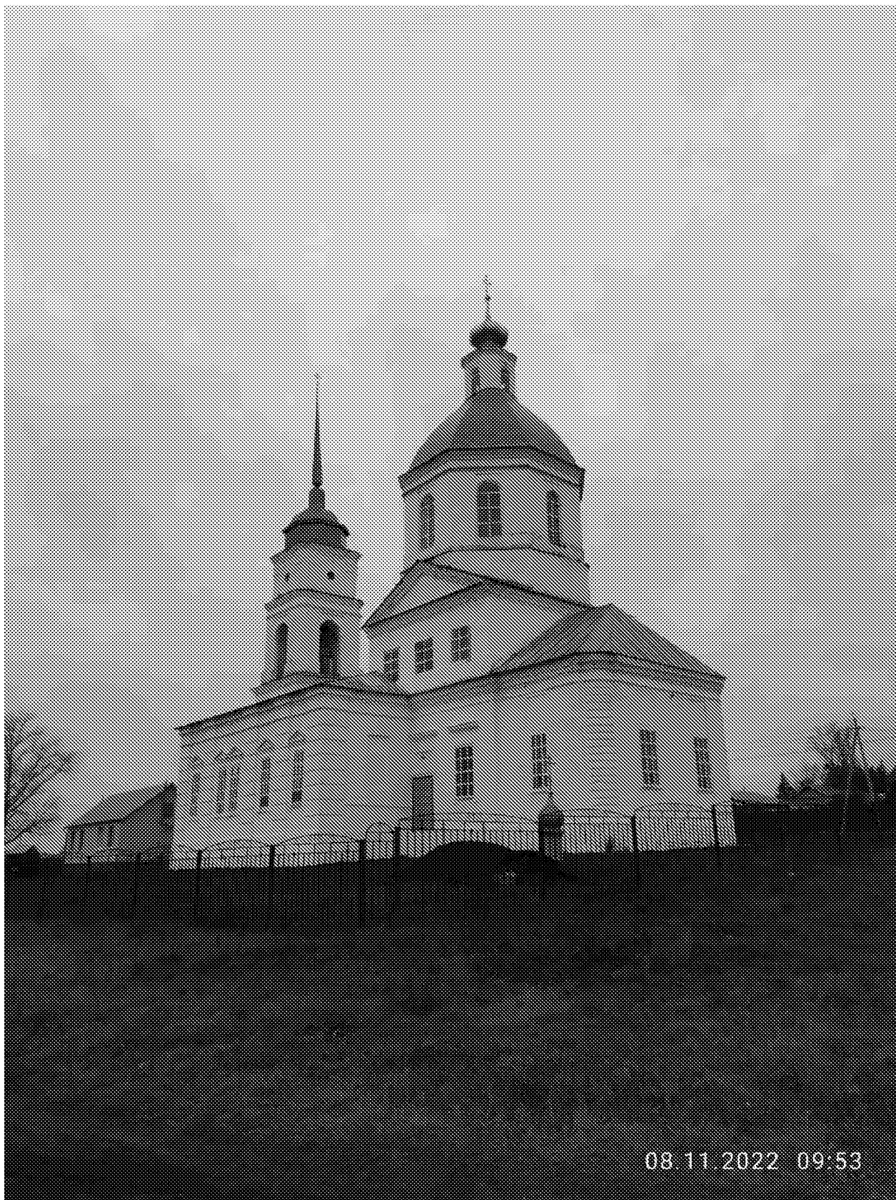
Общий вид объекта культурного наследия с юго-восточной стороны
