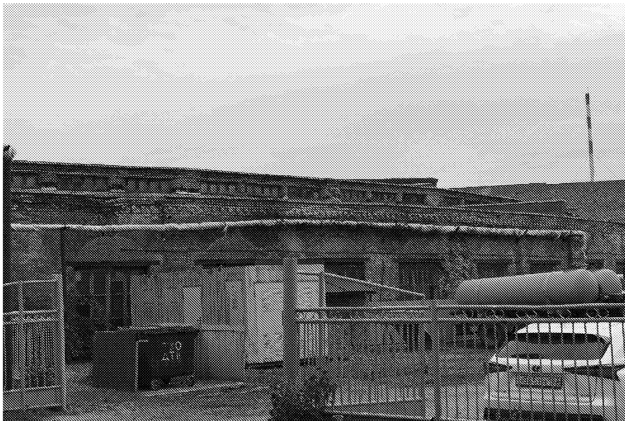
Вид на объект культурного наследия с юго-западной стороны. (21.09.2022)
