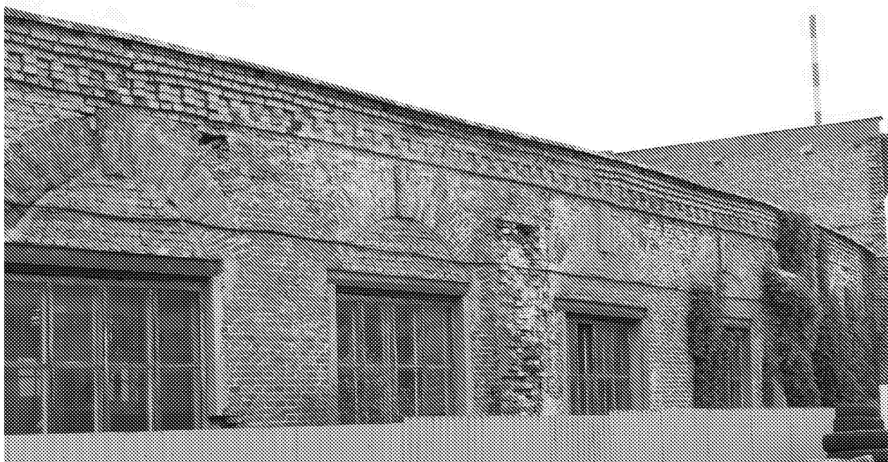
Вид на часть фасада объекта культурного наследия с южной стороны. (21.09.2022)
