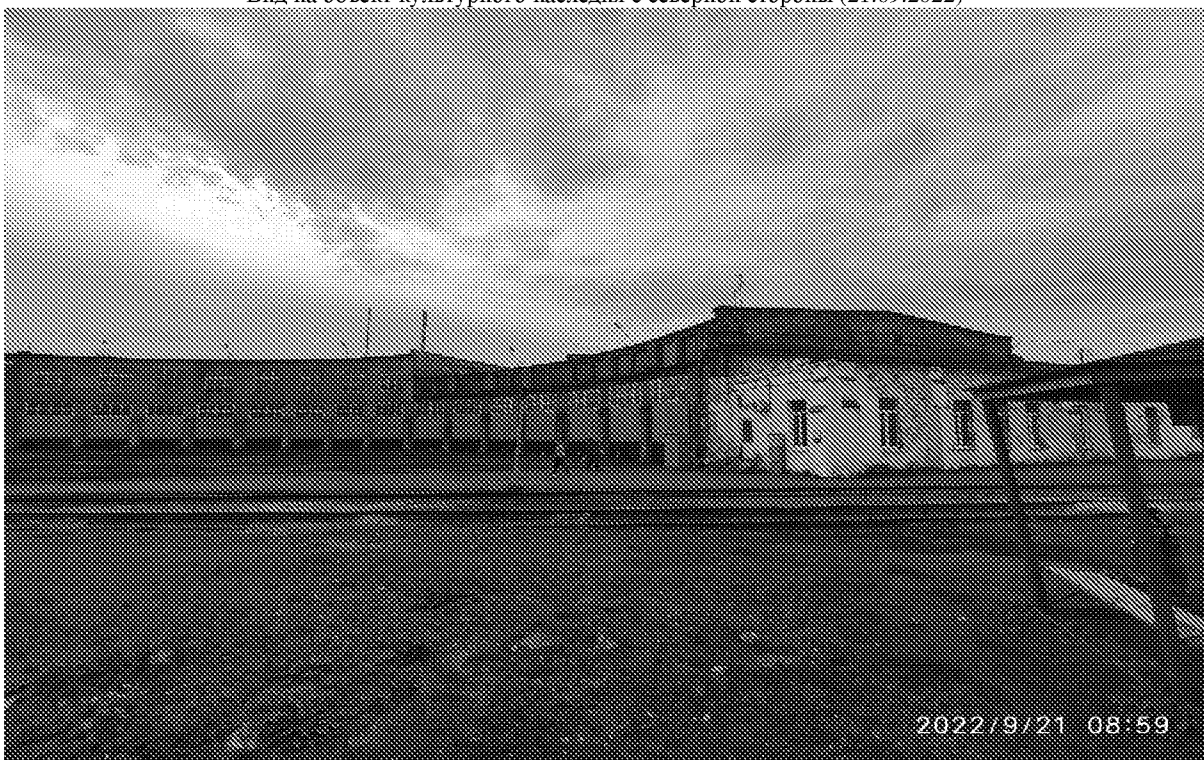
Вид на объект культурного наследия западной стороны (21.09.2022)
