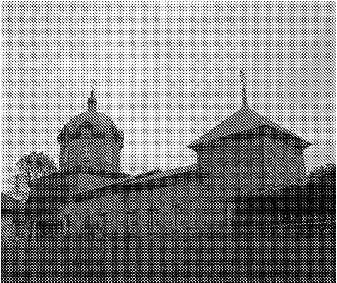
Вид на объект культурного наследия с северной стороны. (07.10.2022)
