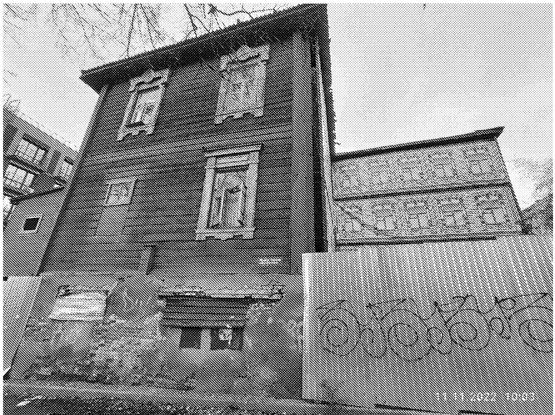
Вид на объект культурного наследия с восточной стороны (11.11.2022)
