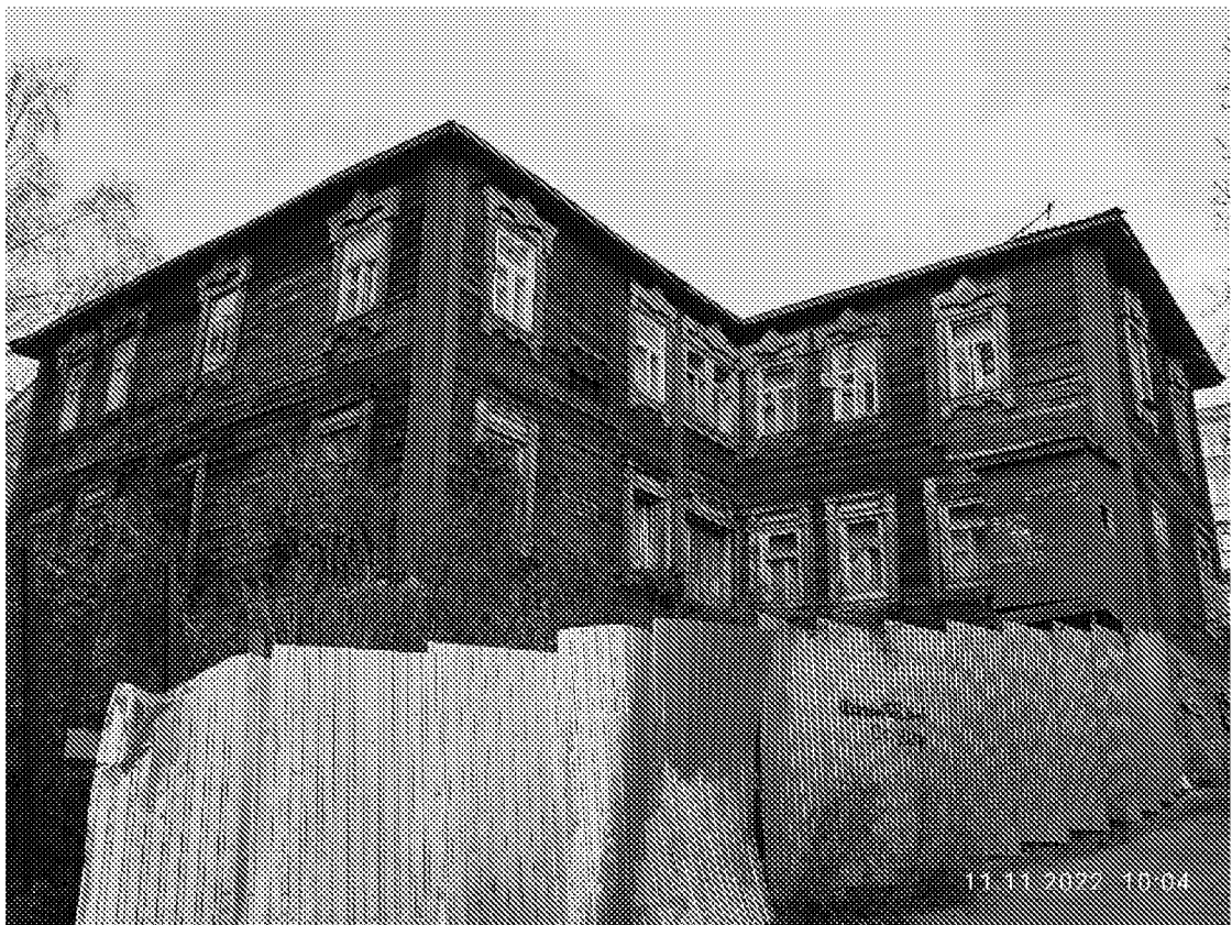
Вид на объект культурного наследия с юго-восточной стороны. (11.11.2022)
