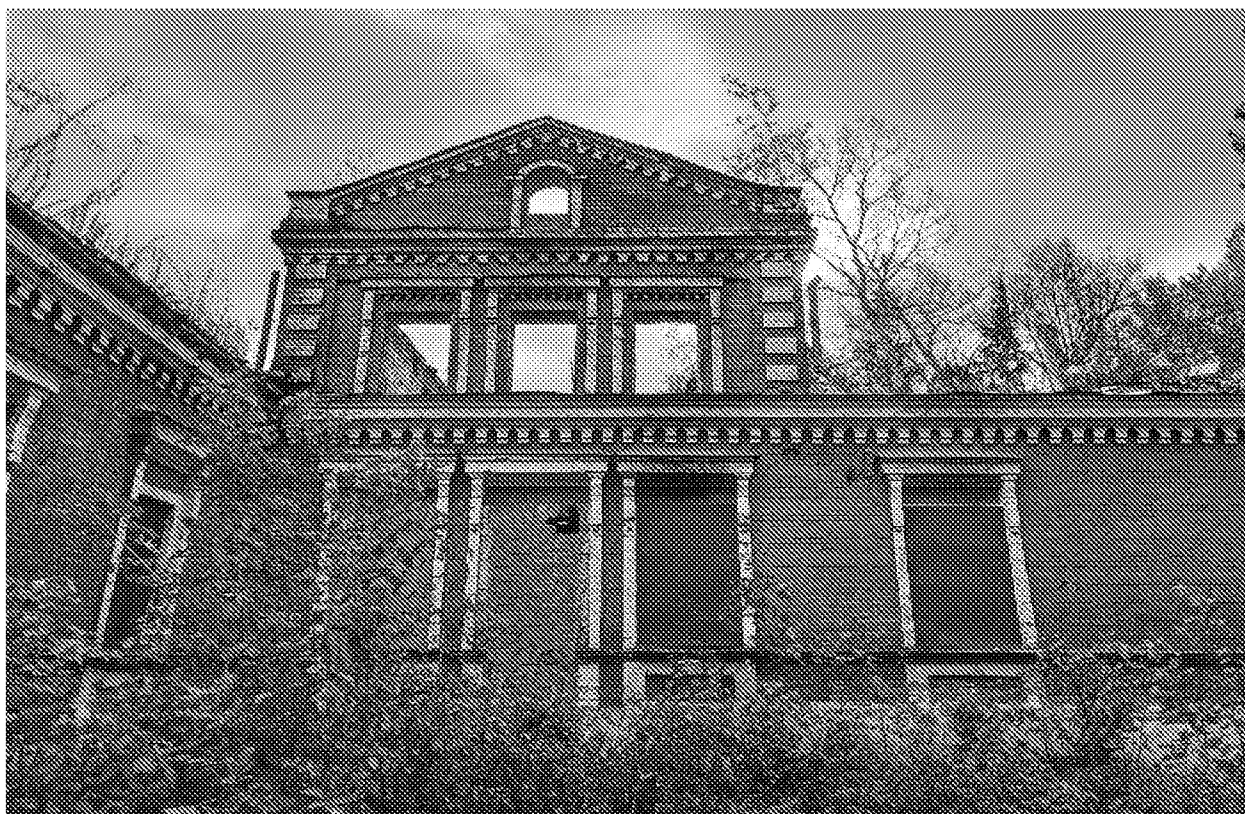
Вид на объект культурного наследия с северо-западной стороны. (07.10.2022)
