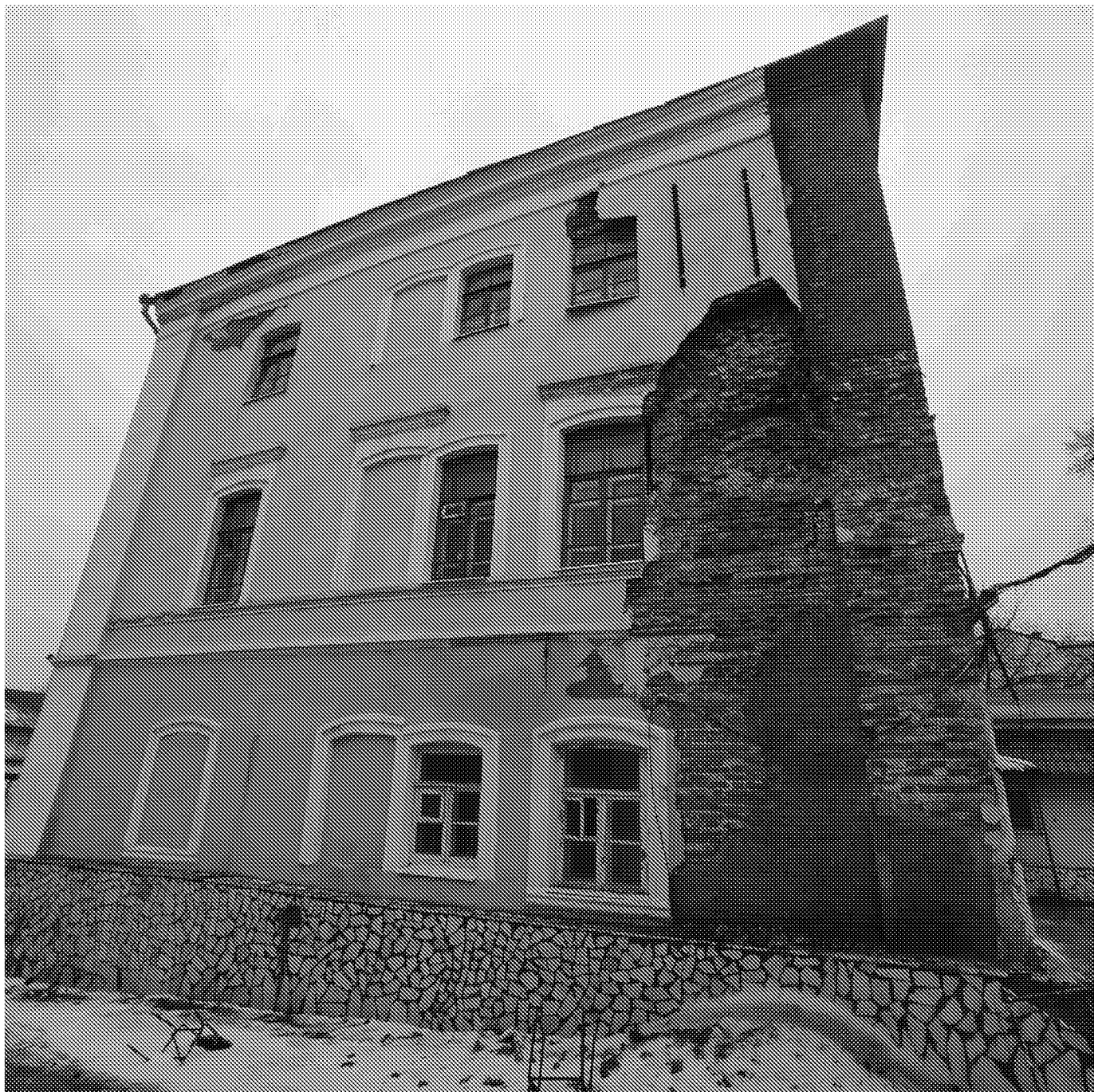
Северный фасад здания (23.12.2022)
