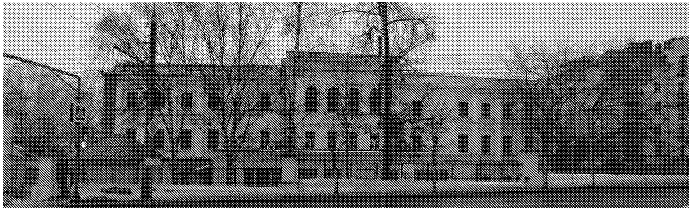
Главный (западный) фасад здания по ул. Кирова (23.12.2022)
