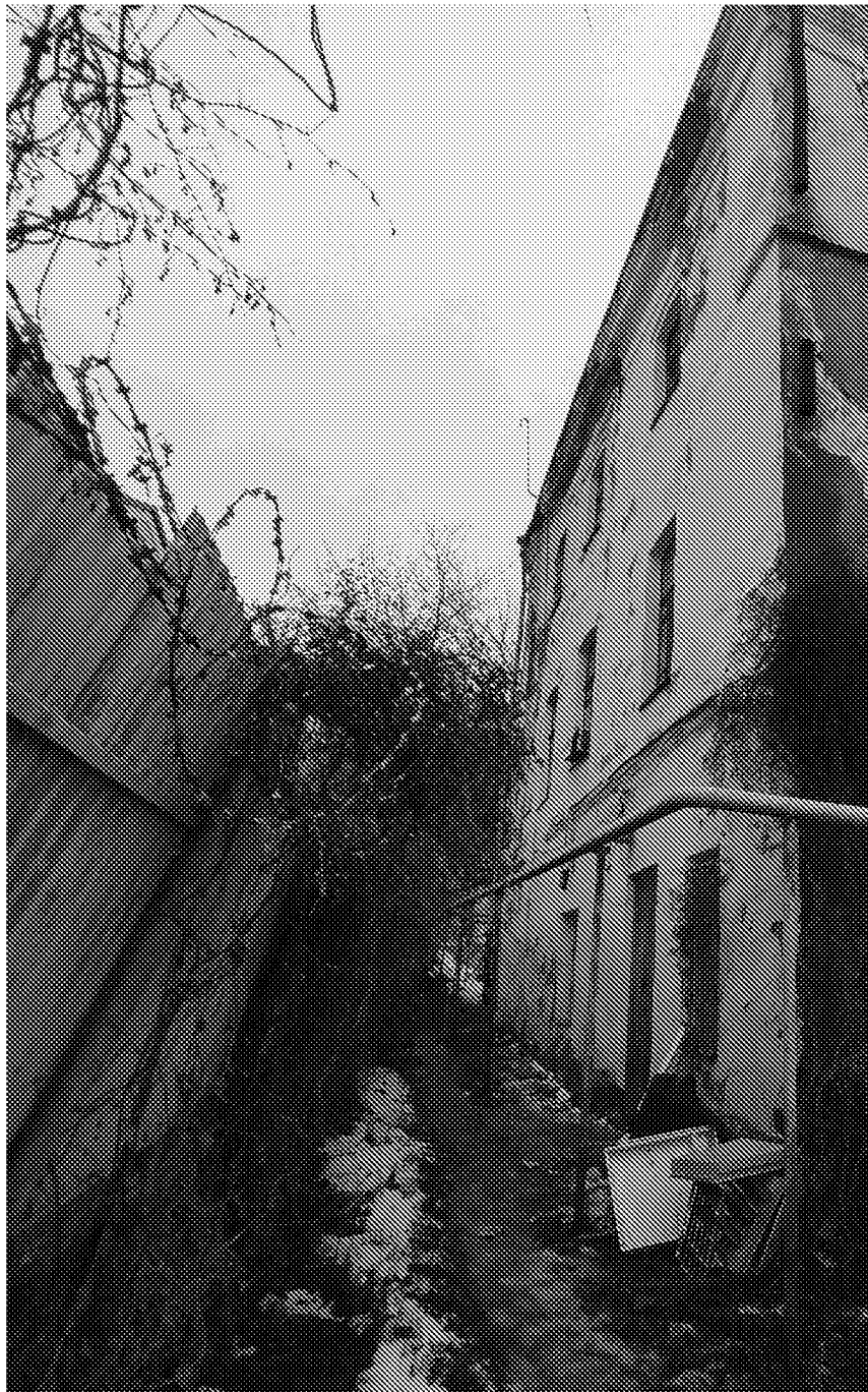
Южный фасад здания (23.12.2022)
