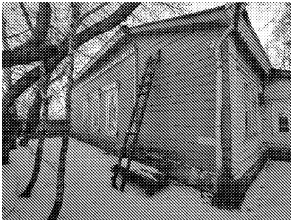
Фото фасада здания с северной стороны (25.01.2023)
