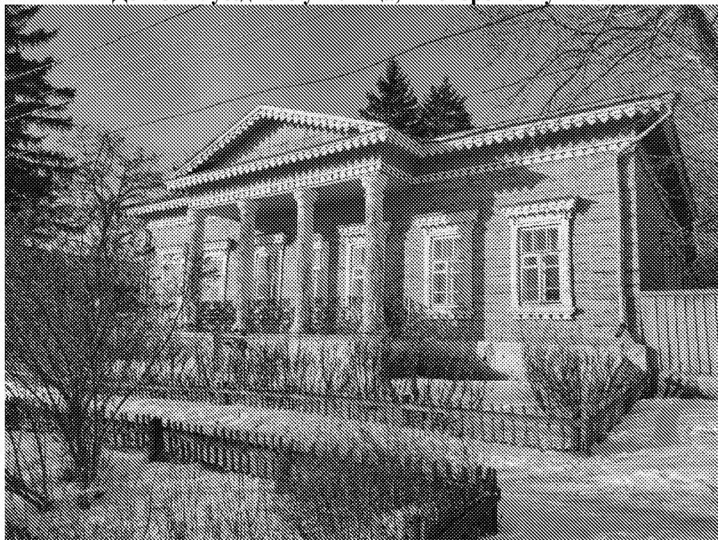
Фото фасада здания с восточной стороны (25.01.2023)
