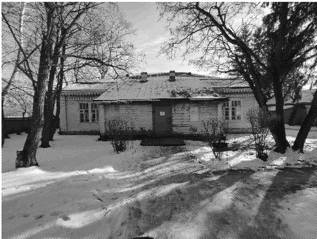
Фото фасада здания с западной стороны (25.01.2023)
