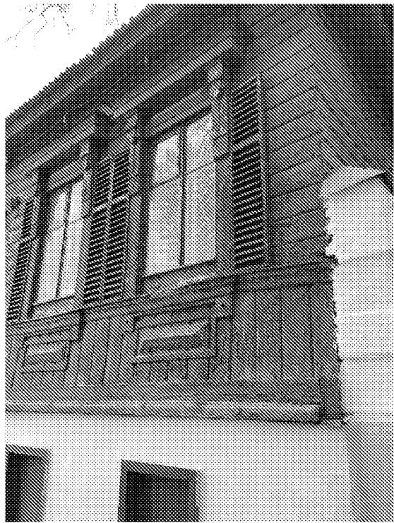
Фактура стен 2-ого этажа - дерево
