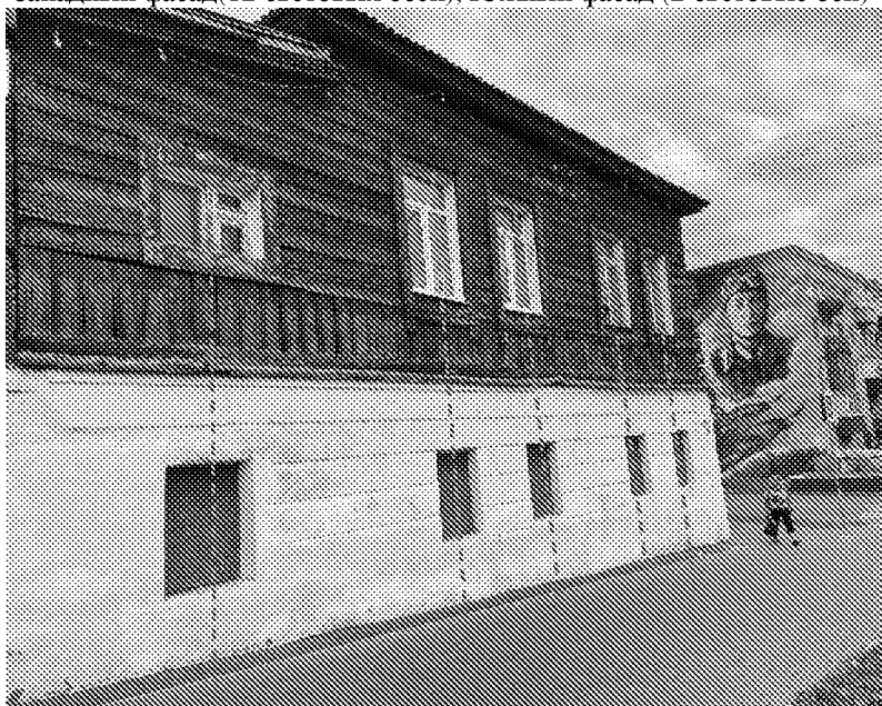
Северный фасад(5 световых осей)
