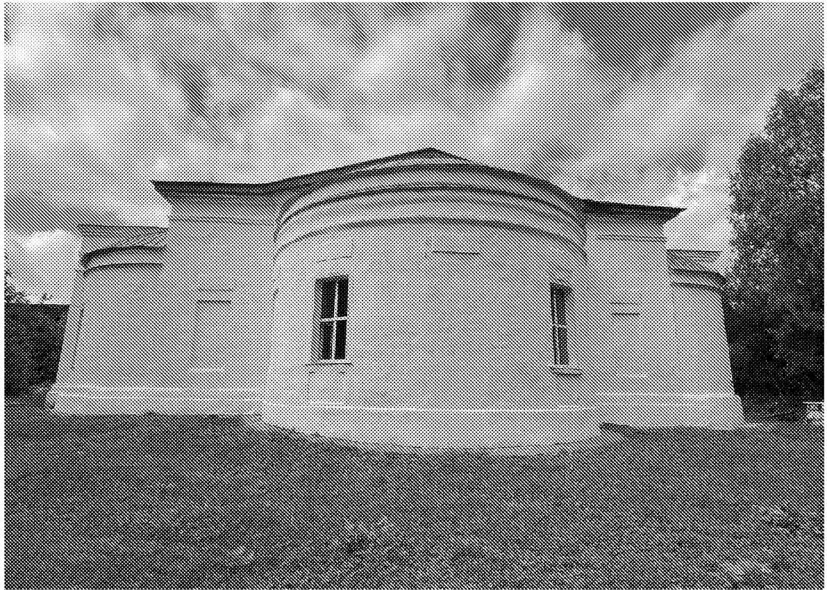
Восточный фасад объекта культурного наследия. Апсида
