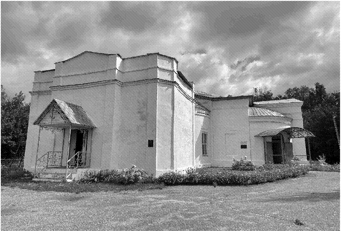
Современный вид объекта культурного наследия. Юго-западный фасад объекта культурного наследия
