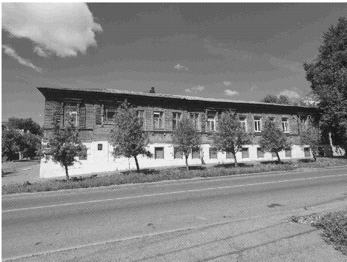
Восточный фасад объекта культурного наследия
