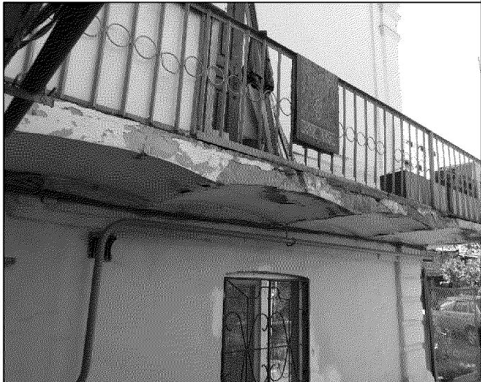
фрагмент северо-восточного дворового фасада литер А объекта культурного наследия (открытая галерея в уровне второго этажа из монолитной железобетонной плиты, выполненной в виде мелкоразмерных сводов с металлическим ажурным ограждением)
