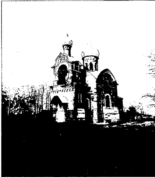
Вид на западный и южный фасады
