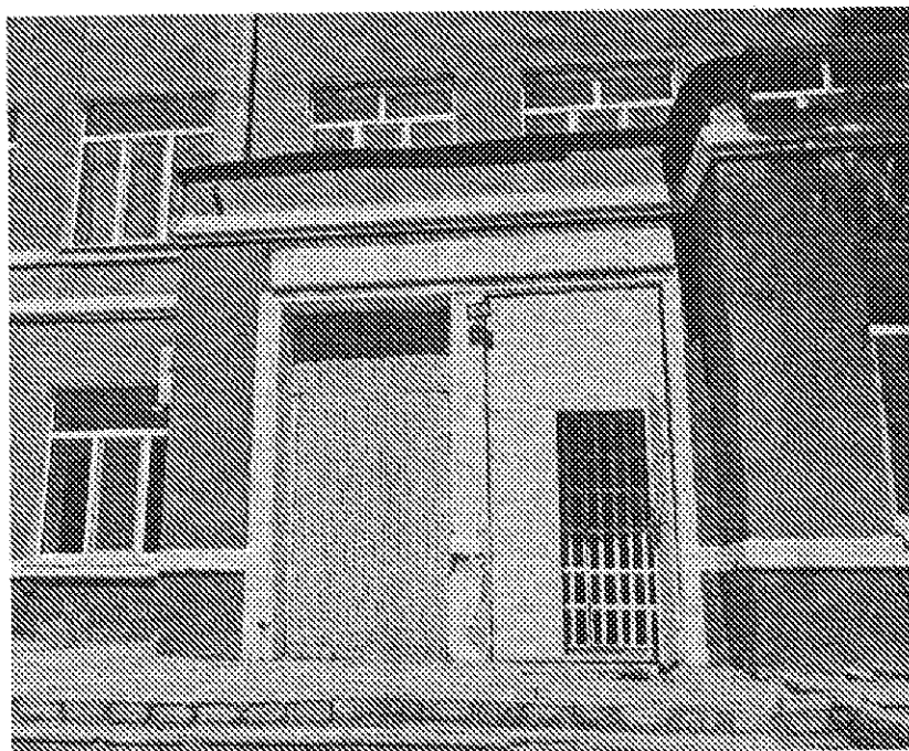
Фрагмент южного (главного) фасада (справа)
