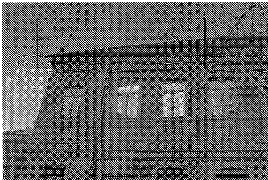
Фото 3. Фрагмент фасада, уровень 2-го этажа.
