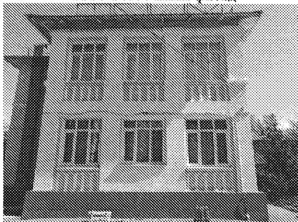
Юго-западный (боковой) фасад
