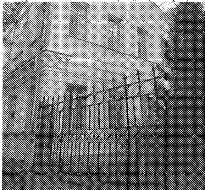
Кованные металлические ограждения сквера по ул. Советская, фрагмент восточного фасада (Литер Г)
