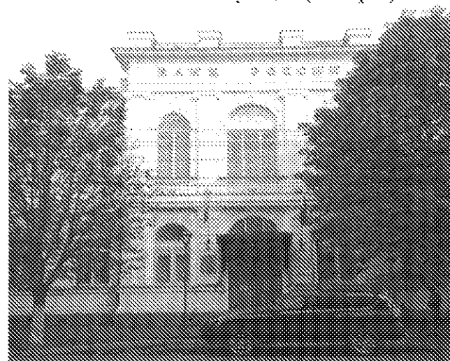
Ризалит южного фасада (Литер Г)
