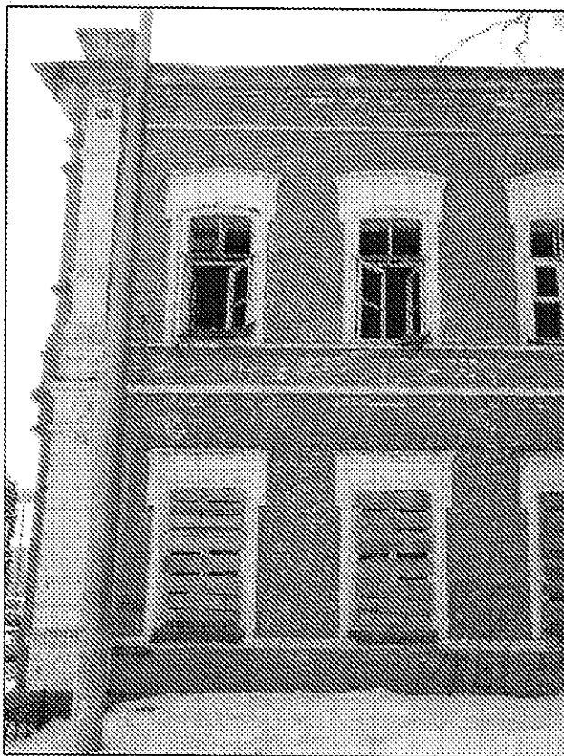
16. Северный (боковой) фасад. Фото 31.03.2021 г. Оконные проемы, горизонтальные членения, вертикальные членения.
