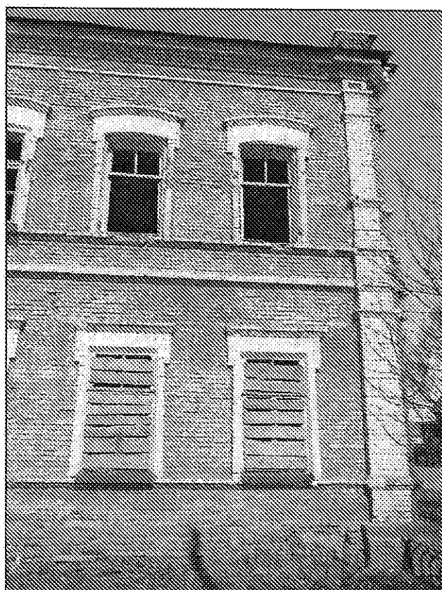
22. Северный (боковой) фасад. Фото 31.03.2021 г. Оконные проемы, горизонтальные членения, вертикальные членения.
