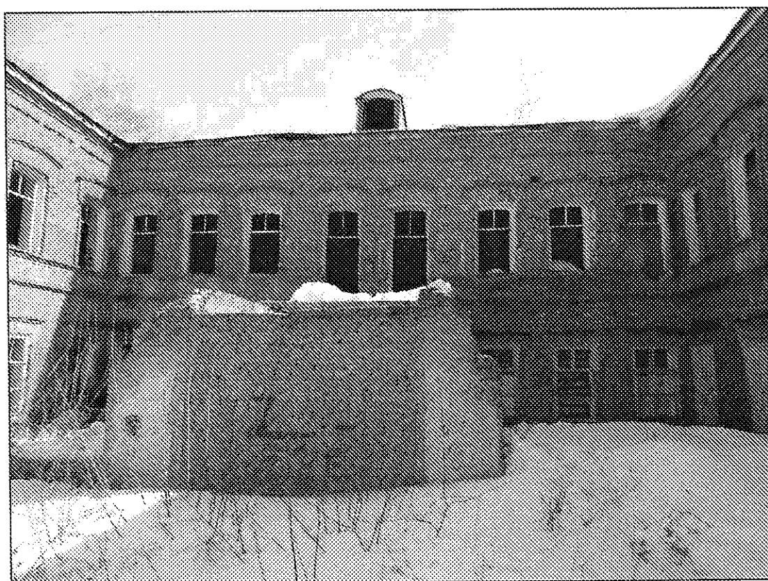
28. Западный (дворовой) фасад. Фото 31.03.2021 г. Композиционное решение фасада. Оконные проемы, горизонтальные членения.
