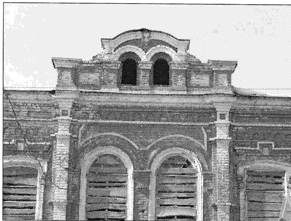
8. Восточный (главный) фасад. Фото 31.03.2021 г. Центральный ризалит: горизонтальные членения, аттик.
