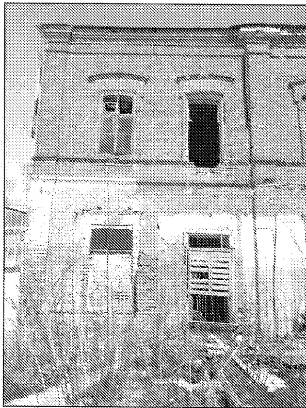
26. Южный (дворовой) фасад. Фото 31.03.2021 г. Оконные проемы, горизонтальные членения, вертикальные членения.
