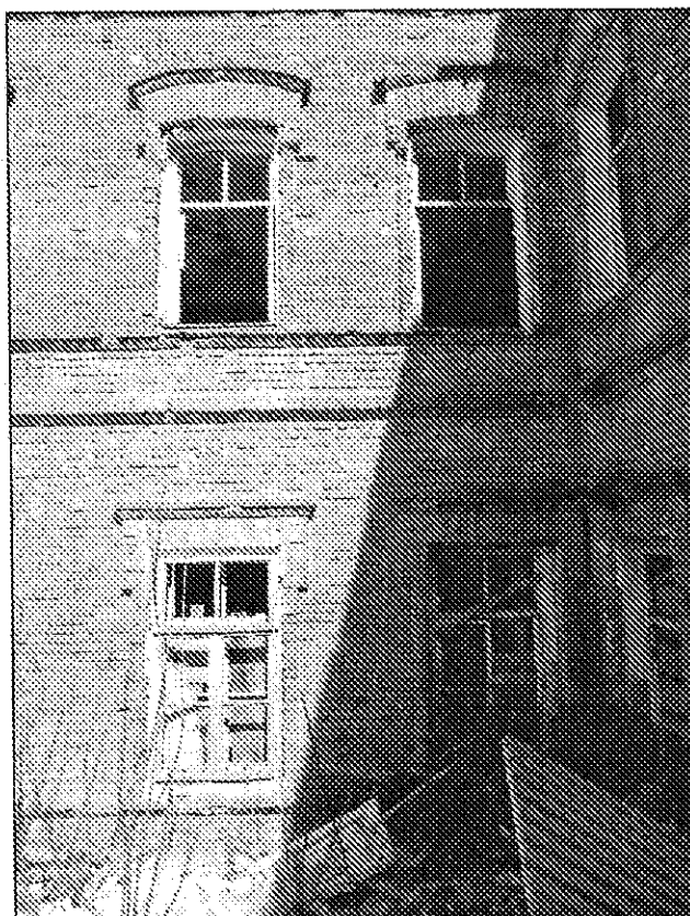
27. Южный (дворовой) фасад. Фото 31.03.2021 г. Оконные проемы, горизонтальные членения.
