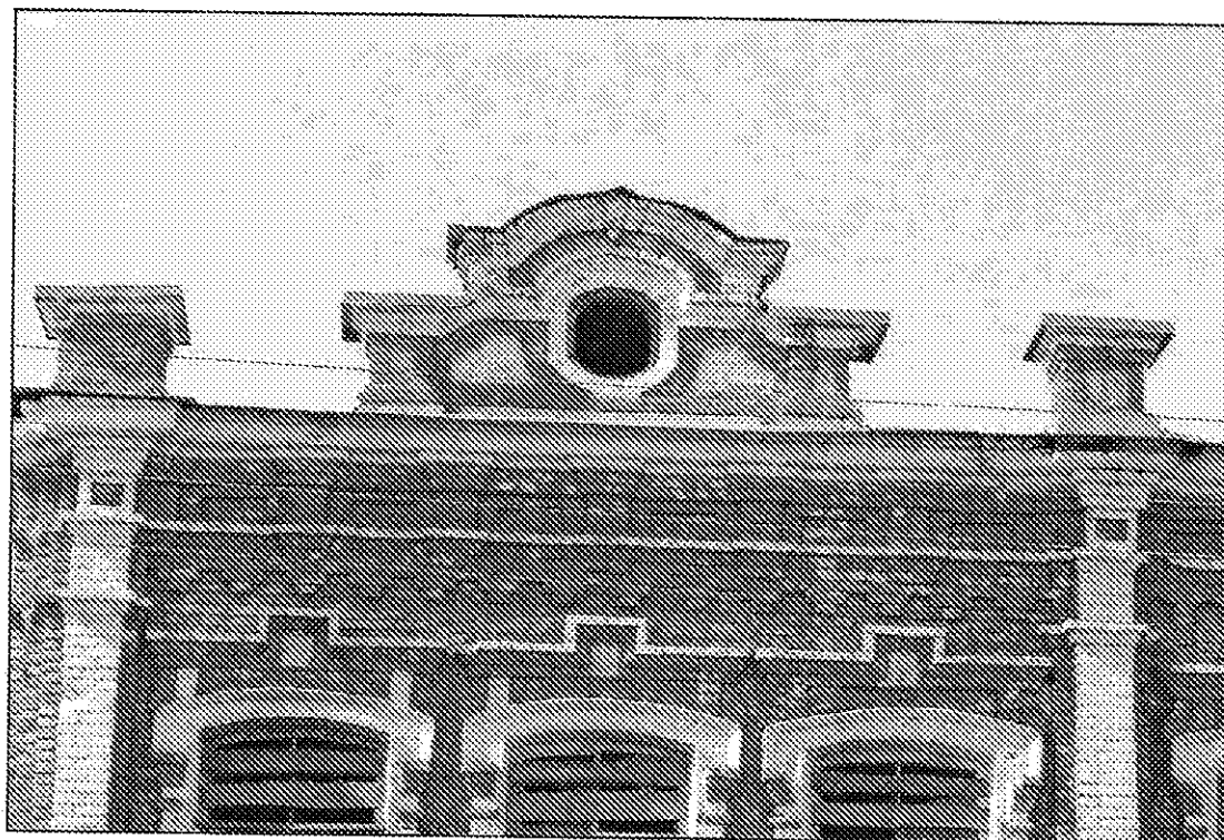
13. Восточный (главный) фасад. Фото 31.03.2021 г.
