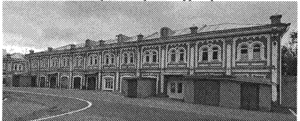
Главный фасад здания со стороны дворовой территории
