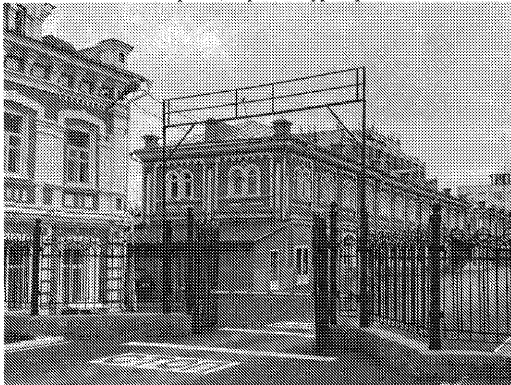
Главный фасад здания со стороны дворовой территории
