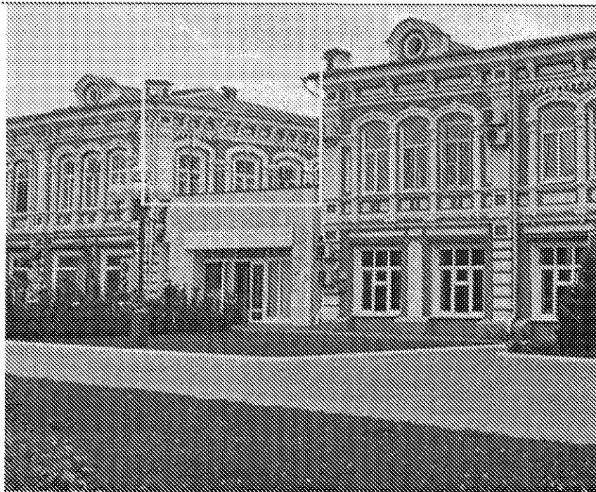
Боковой фасад здания (часть фасада 2 этажа)
