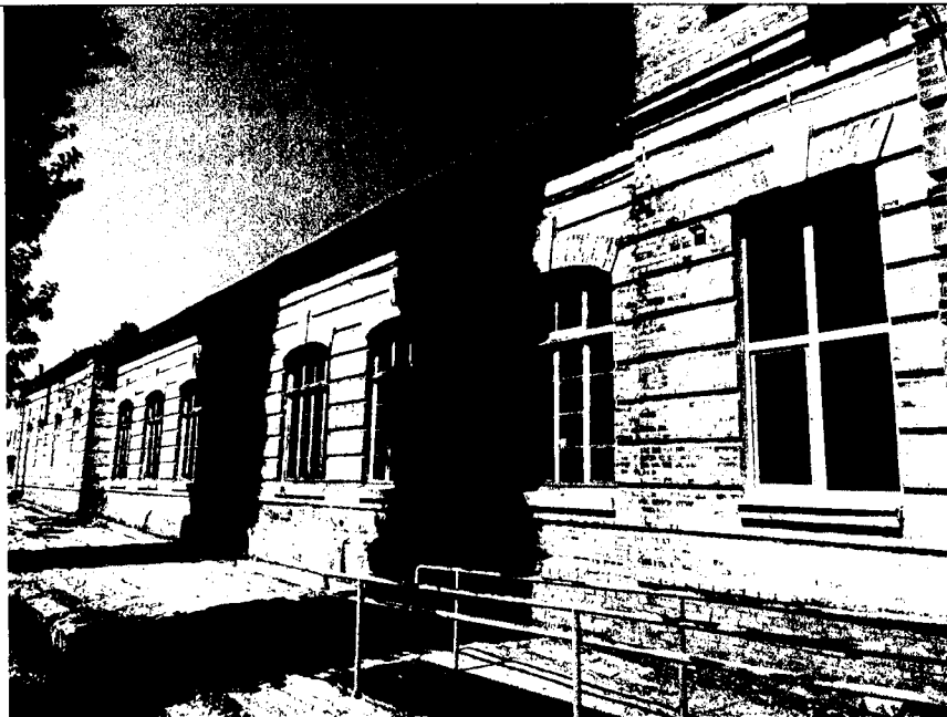
Фото 19. Вид на боковой фасад Объекта
