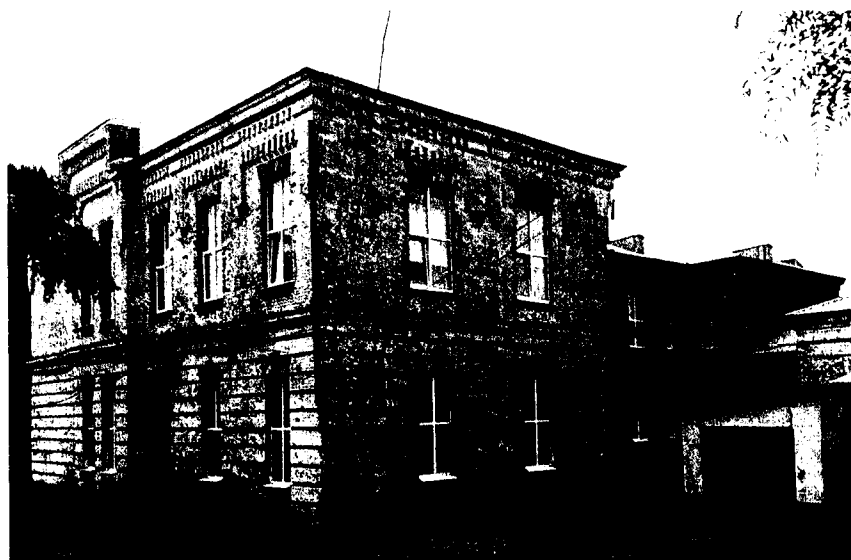
Фото 6. Вид на дворовой фасад Объекта
