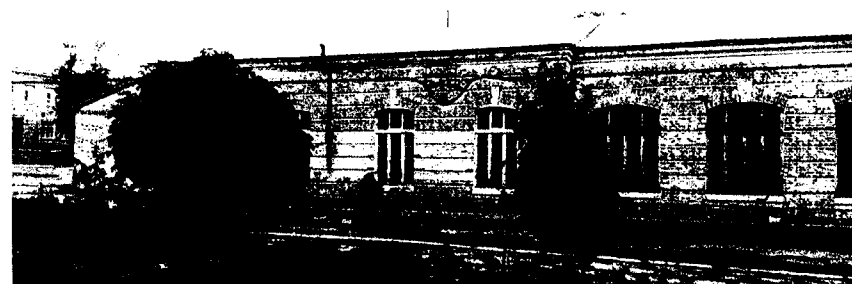
Фото 17. Вид на боковой фасад Объекта
