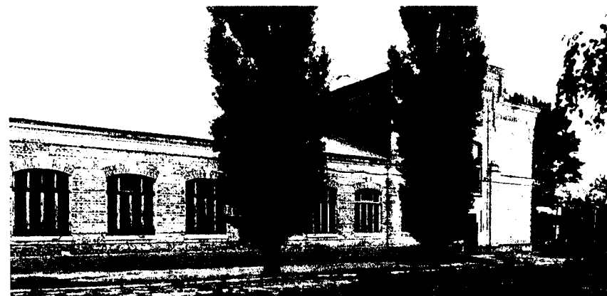
Фото 18. Вид на боковой фасад Объекта
