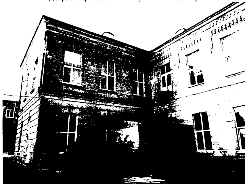
Фото 8. Вид на дворовой фасад Объекта
