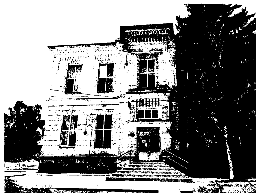
Фото 3. Вид на вход главного фасада Объекта
