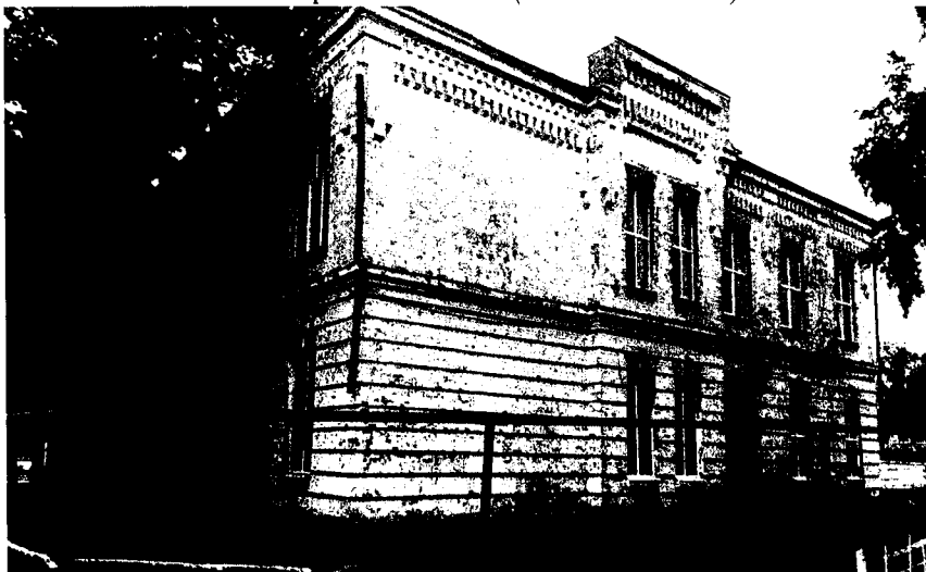
Фото 4. Вид на боковой фасад Объекта
