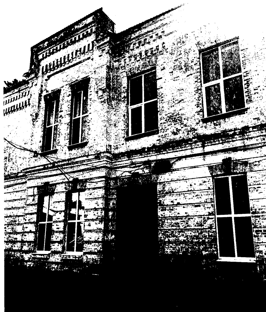
Фото 5. Вид на боковой фасад Объекта
