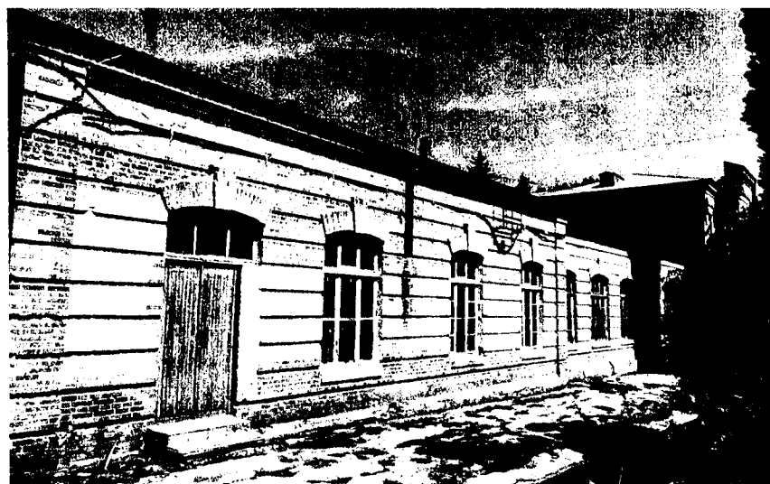
Фото 16. Вид на боковой фасад Объекта
