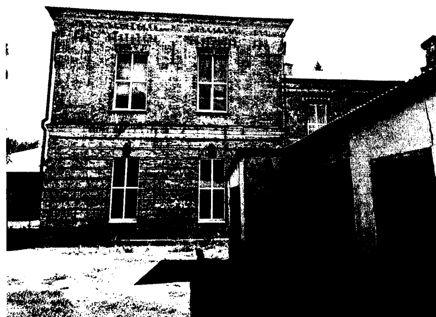
Фото 7. Вид на дворовой фасад Объекта
