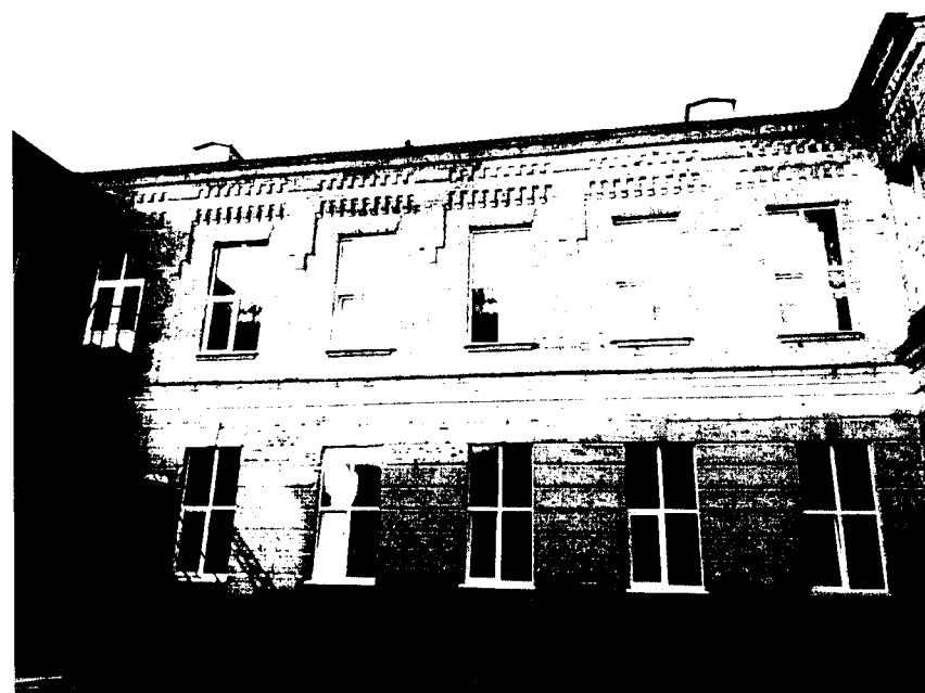
Фото 9. Вид на дворовой фасад Объекта
