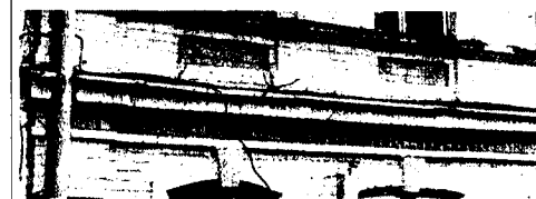
Межэтажный профилированный поясок с поребриком
