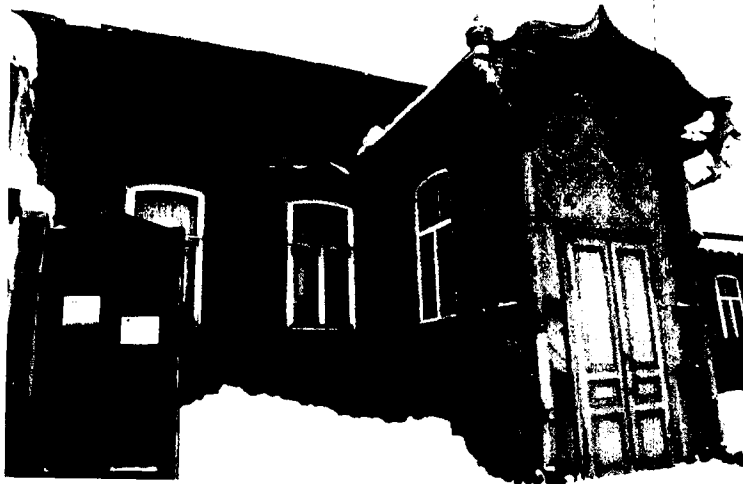
Боковой (восточный) фасад, правая часть
