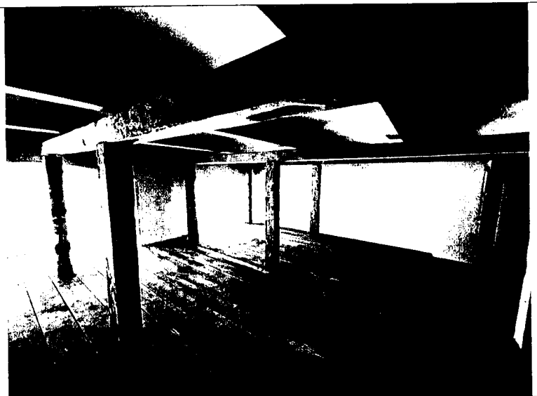
Помещение 20: 6.37. Книгохранилище Встроенный каркас: колонны и ригели.
