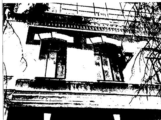
Оконные проемы второго этажа
