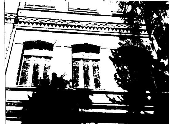
Оконные проемы второго этажа
