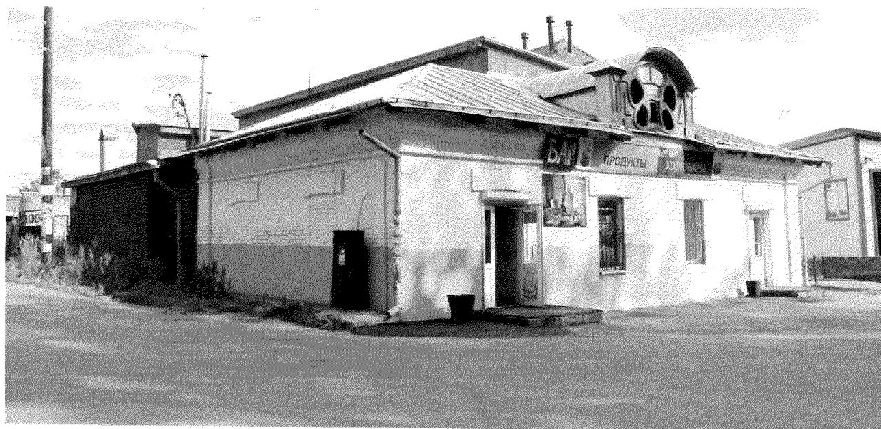
Видовая точка № 3. Общий вид здания с ул. Алеутской.
