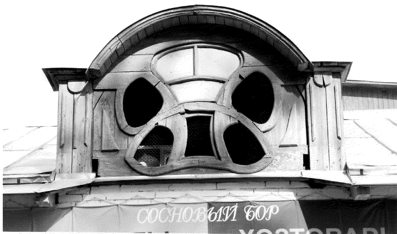
Видовая точка № 4. Слуховое окно главного фасада.
