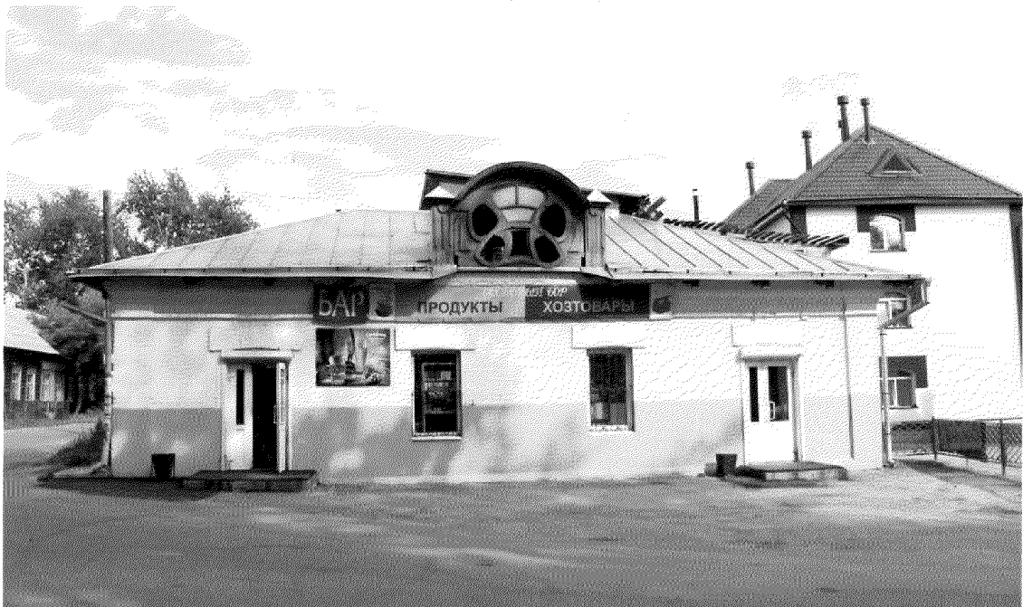
Видовая точка № 2. Главный (западный) фасад здания.
