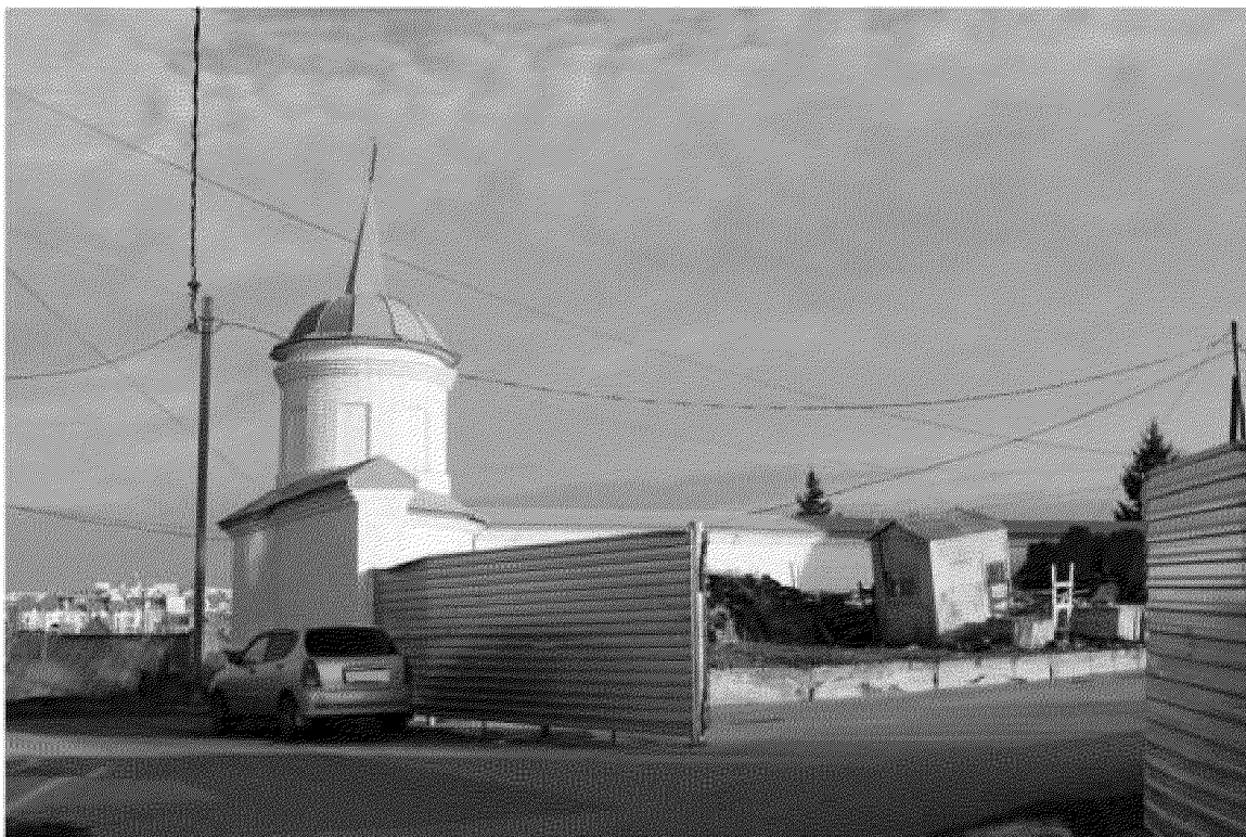
Фото 2. Фрагмент северо-восточной части ограждения территории. Автор снимка: Гришанова А.Ю., дата съемки: 17.09.2014 г.
