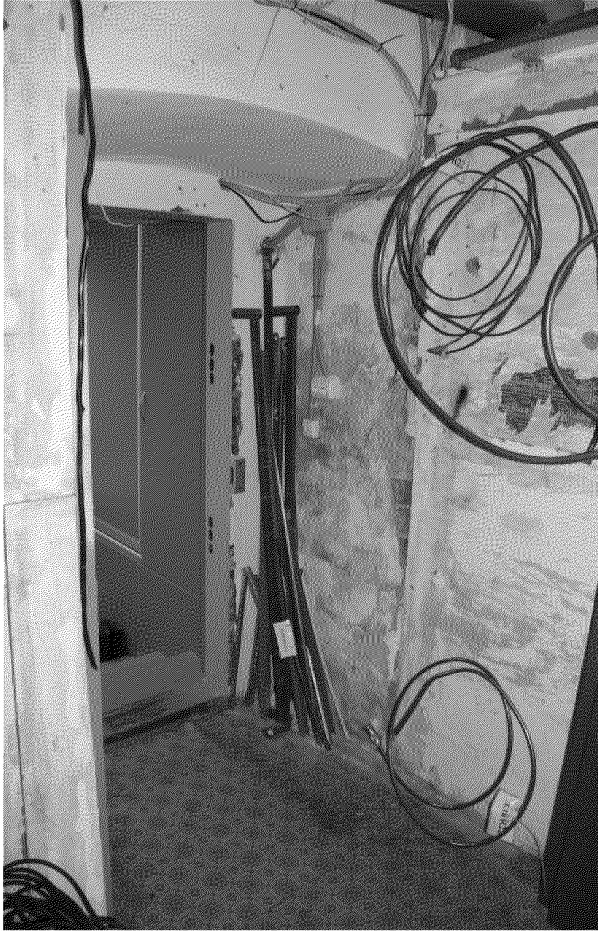
Видовая точка № 16. Лучковый дверной проем подвала.
