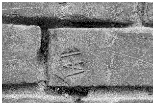
Видовая точка № 11. Фрагмент кирпичной кладки с клеймом завода- изготовителя И. Некрасова.
