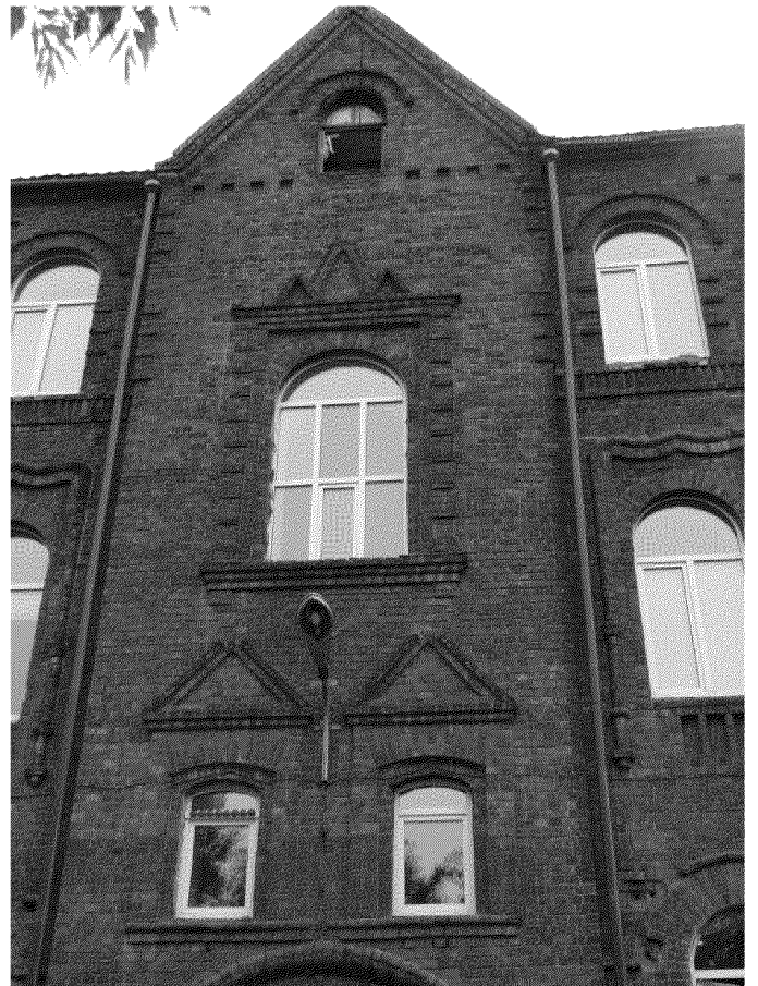
Видовая точка № 7. Декор центрального ризалита главного фасада. Форма и расположение оконных проемов.
