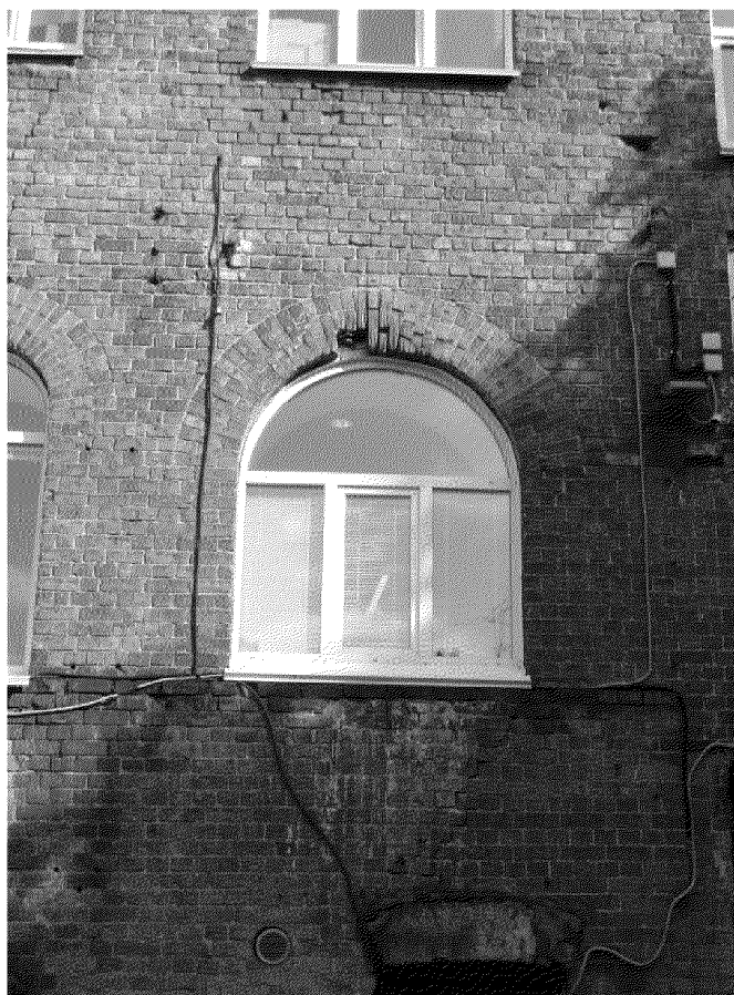
Видовая точка № 14. Арочный проем окна (1-й этаж) юго-западного фасада.
