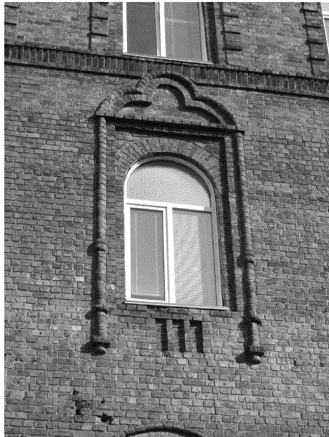
Видовая точка № 13. Арочный проем окна (2-й этаж) и его декоративное оформление. Юго-западный фасад.
