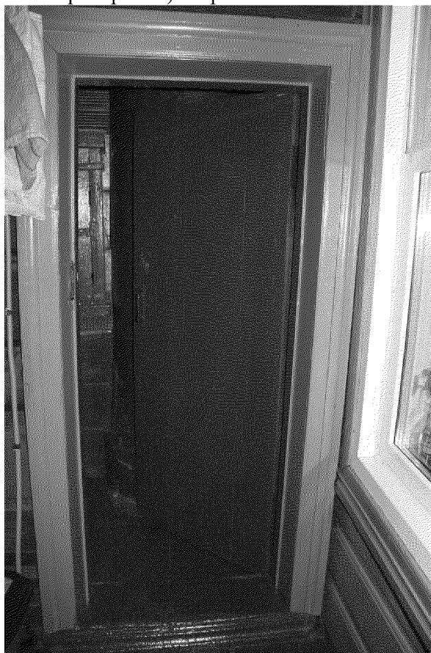
Видовая точка № 19. Дверь входа в подсобное помещение пристройки
