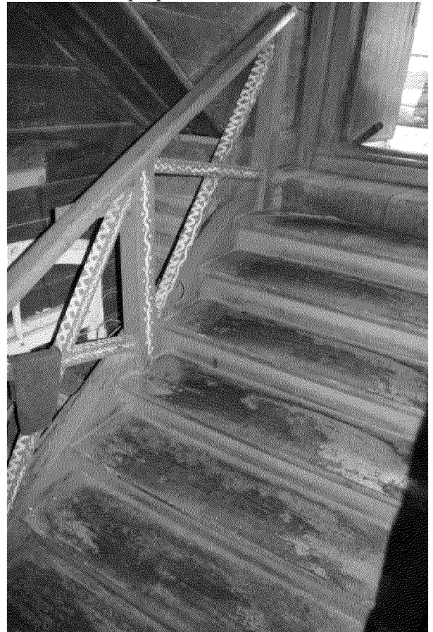
Видовая точка № 16. Деревянная лестница с ограждением
