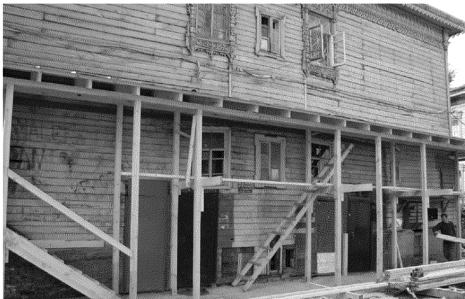
Видовая точка № 11. Фрагмент северного фасада пристройки
