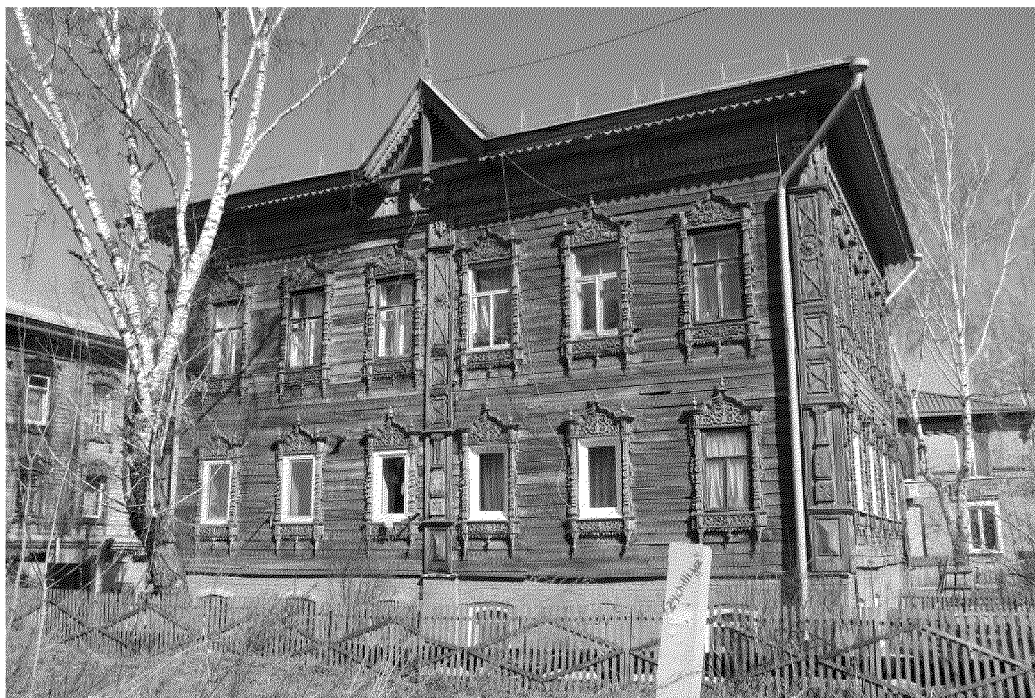
Видовая точка № 1. Южный фасад здания
