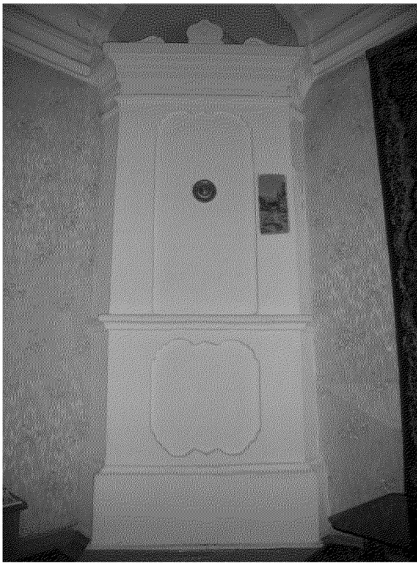
Видовая точка № 21. Угловая голландская печь, профильные потолочно-стенные тяги.
