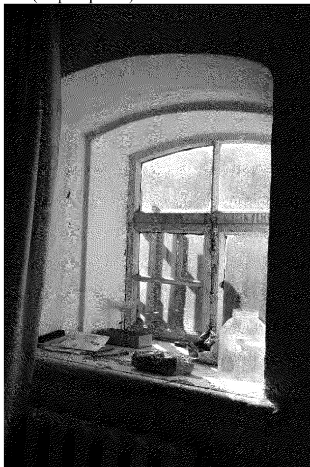
Видовая точка № 20. Лучковое окно цокольного этажа с деревянным профильным подоконником
