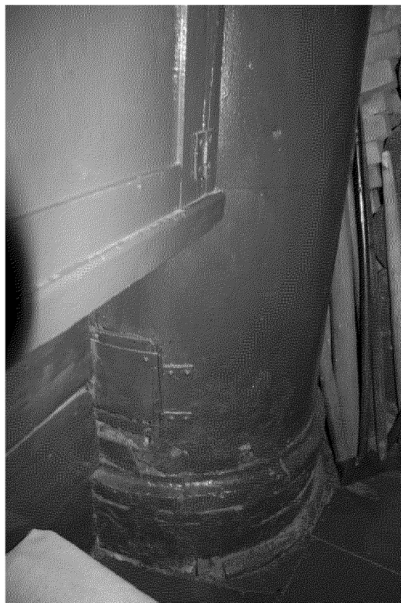
Видовая точка № 18. Круглая печь в металлическом футляре (в пристройке). Нижняя часть печи.
