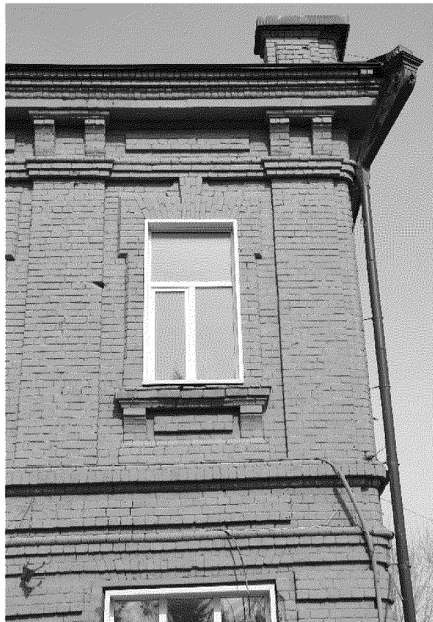
Видовая точка № 7 Фрагмент торцевого (южного) фасада (Яблонская М.А., 12.04.2018)
