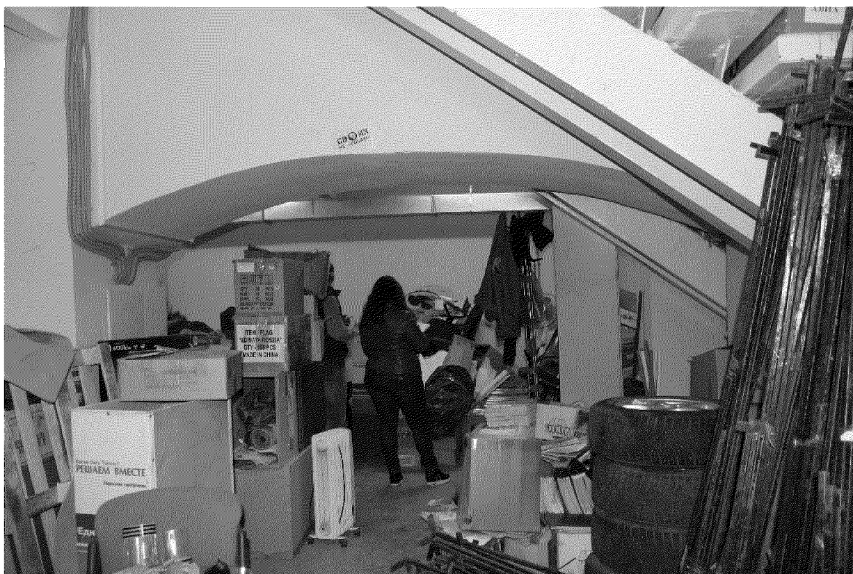
Видовая точка № 11 Фрагмент помещения подвала. Лучковая арка. (Лырова Е.В., 28.04.2017)
