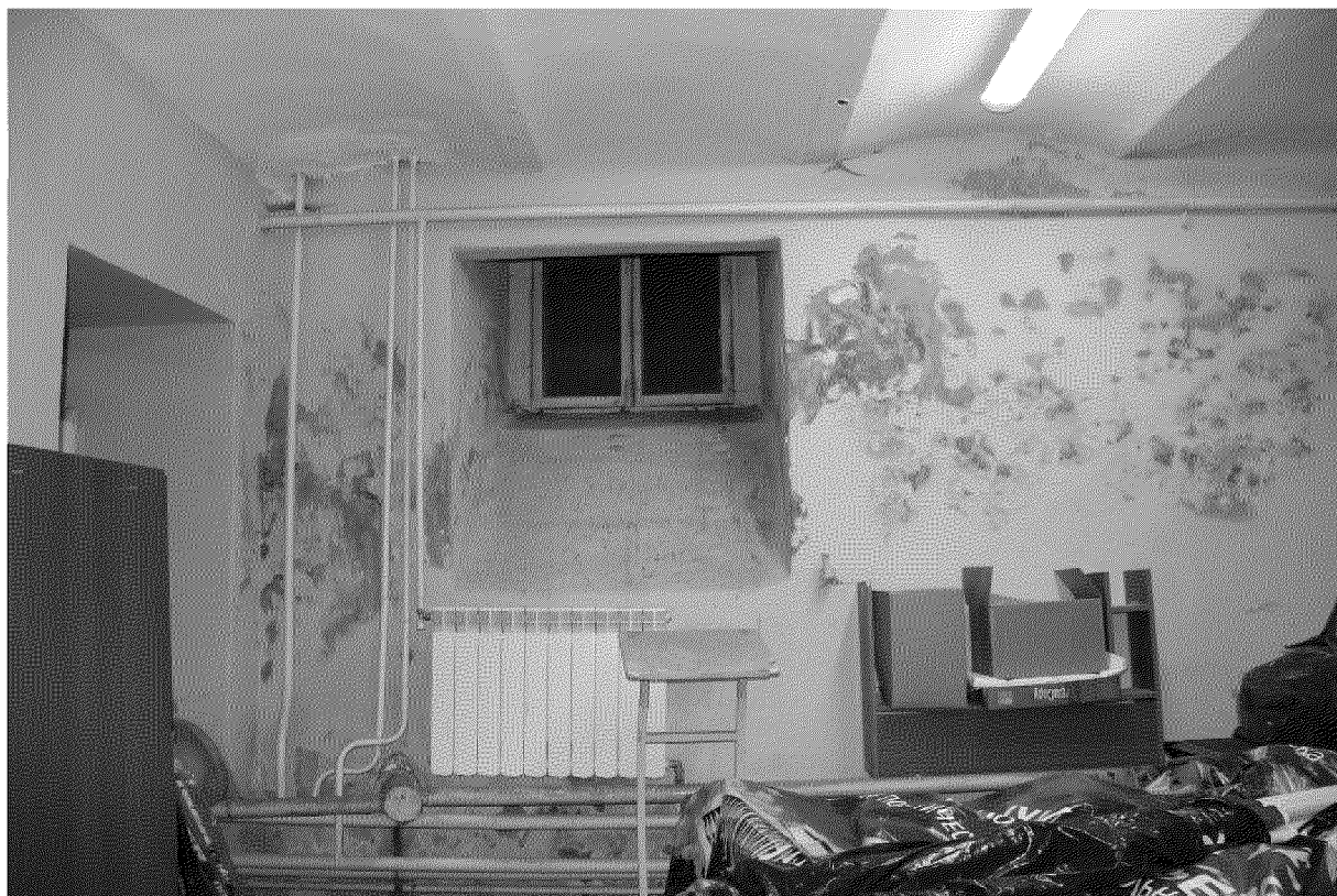
Видовая точка № 10 Фрагмент помещения подвала. Кирпичные своды перекрытия. Окно подвала. (Лырова Е.В., 28.04.2017)
