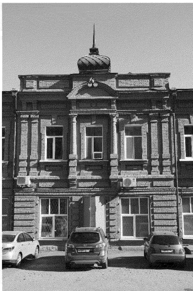
Видовая точка № 4 Фрагмент западного фасада. Ризалит (Яблонская М.А., 04.10.2016)
