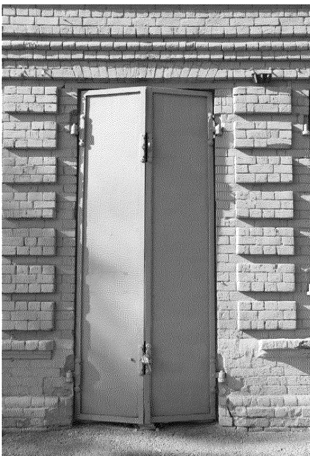
Видовая точка № 8 Металлические ставни дверного проема (Яблонская М.А., 12.04.2018)
