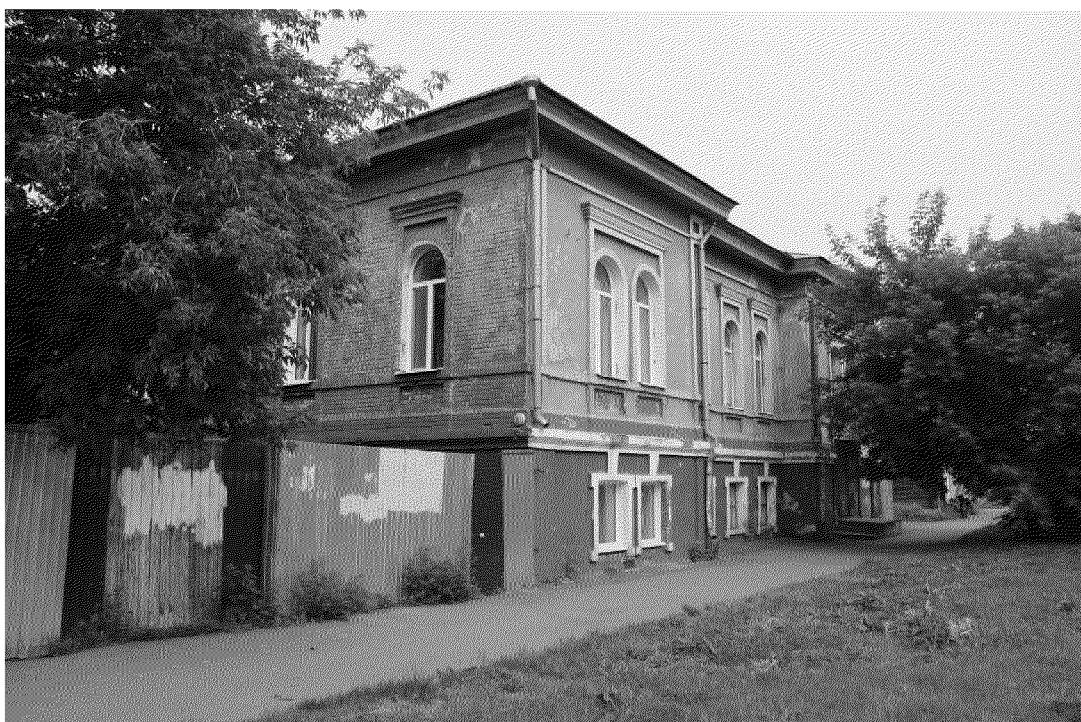
Видовая точка № 2 Общий вид здания по ул. Крылова (Льрова Е.В., 24.07.2019)
