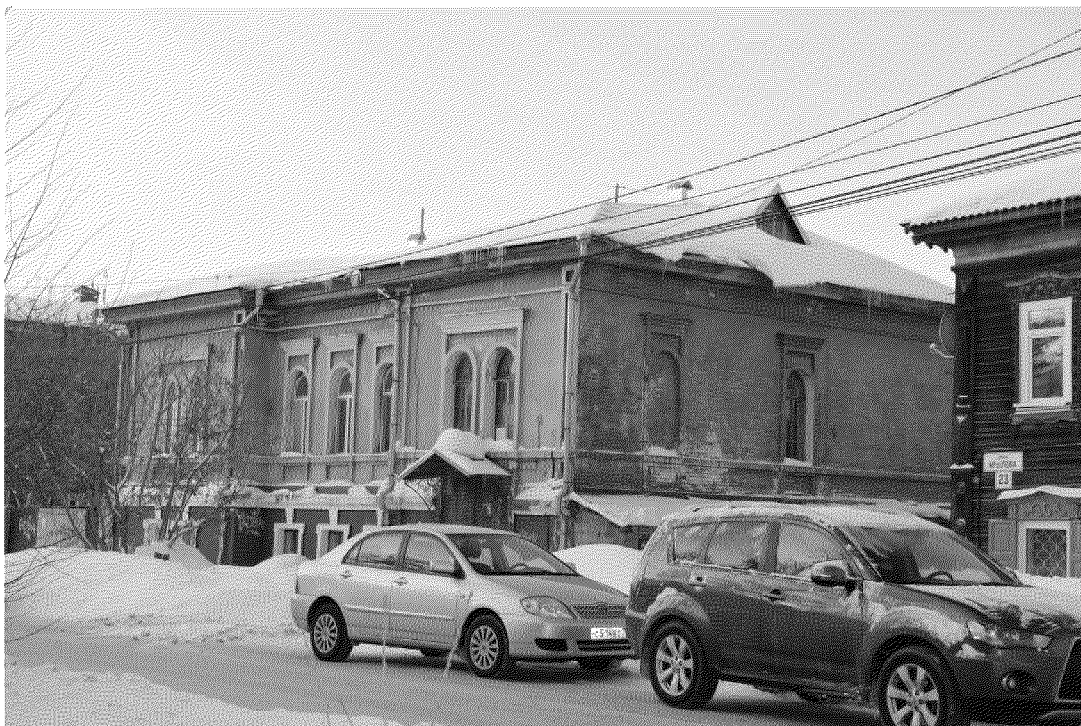
Видовая точка № 1 Общий вид здания по ул. Крылова (Рыжикова А.Ю., 16.12.2016)
