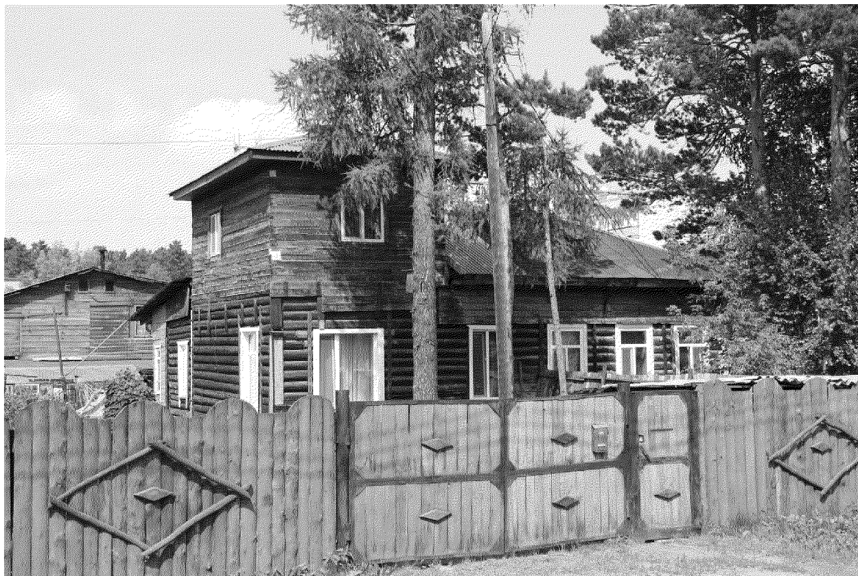
Видовая точка № 3 Общий вид здания с юго-восточной стороны.
