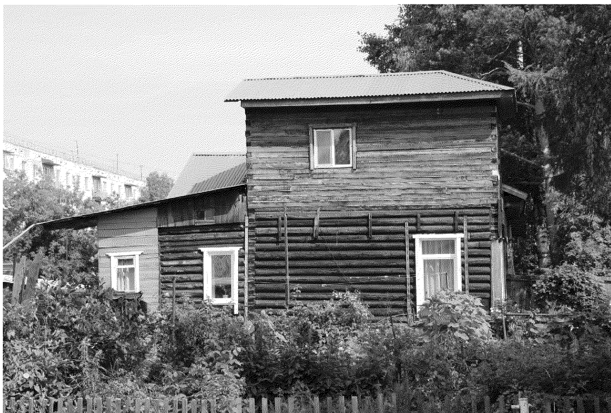
Видовая точка № 4 Южный фасад здания. Вид с территории внутри квартального проезда.
