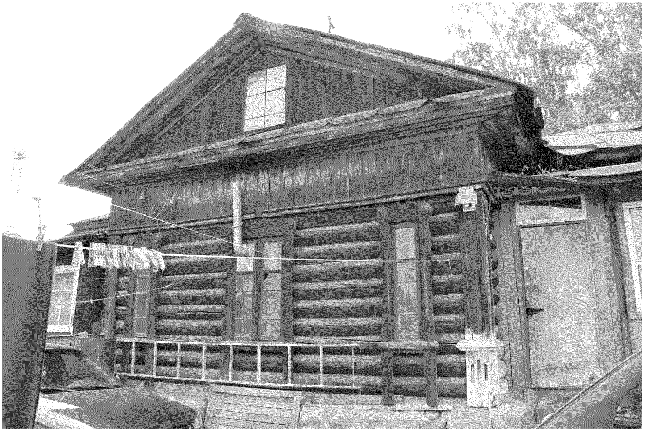
Видовая точка № 8 Центральный ризалит дворового (восточного) фасада.
