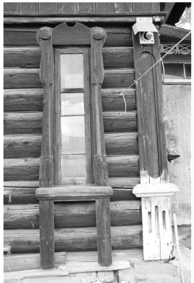
Видовая точка № 10 Фрагмент дворового (восточного) фасада. Окно с наличником.
