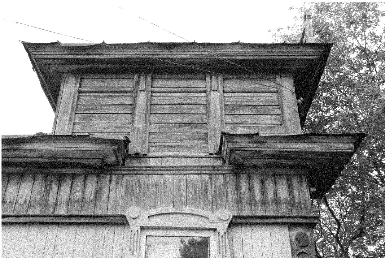
Видовая точка № 6 Фрагмент северного фасада. Угловая башня.
