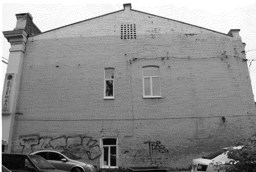
Видовая точка № 8. Торцевой (северный) фасад здания
