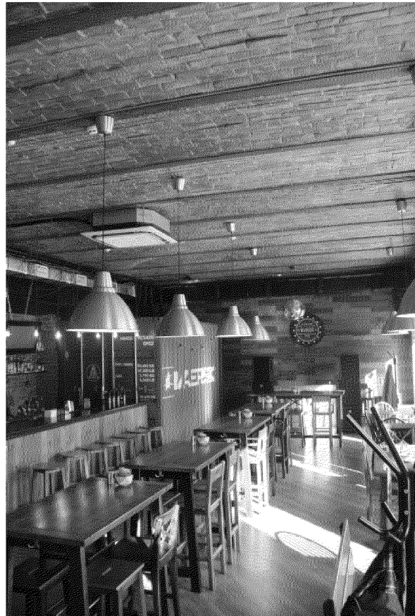
Видовая точка № 17 Фрагмент интерьера помещения 1-го этажа. Кирпичные своды
