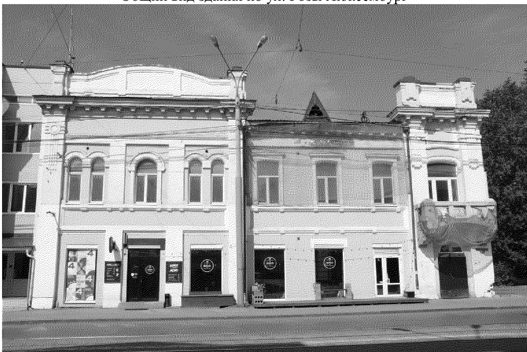
Видовая точка № 2 Главный (восточный) фасад здания
