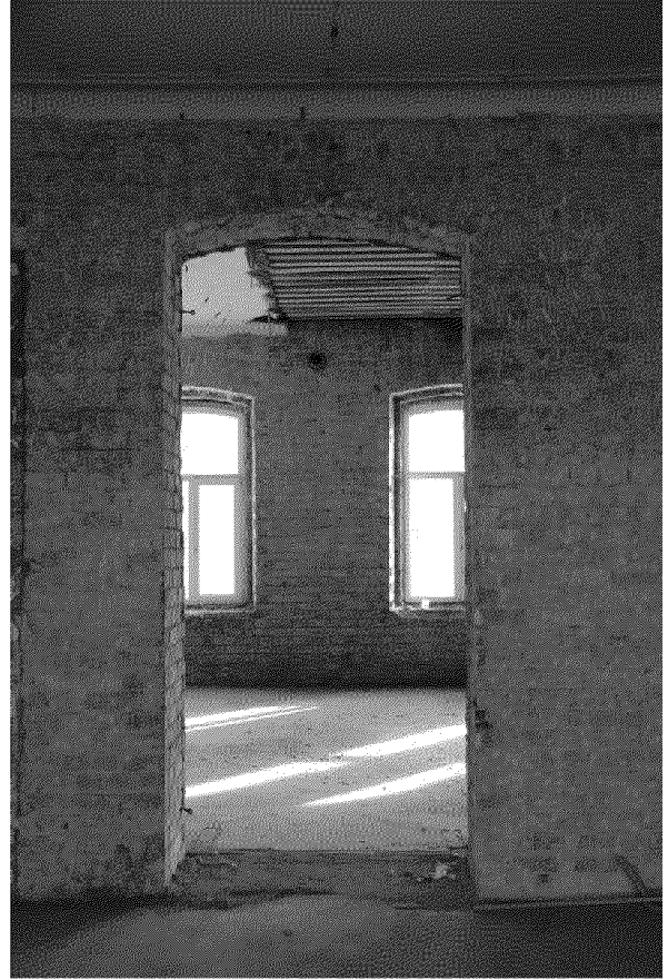
Видовая точка № 25 Лучковый дверной проем (Яблонская М.А., 27.09.2019)
