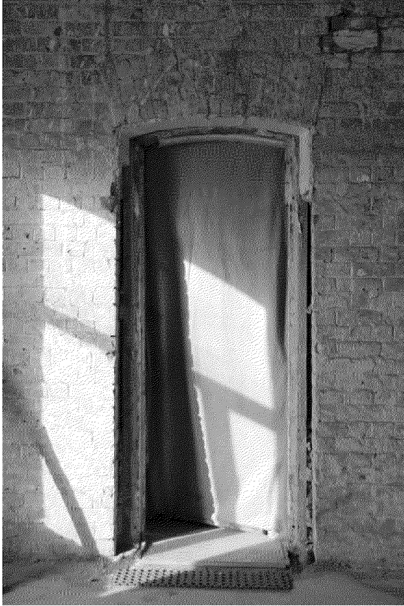
Видовая точка № 24 Лучковый дверной проем (Яблонская М.А., 27.09.2019)
