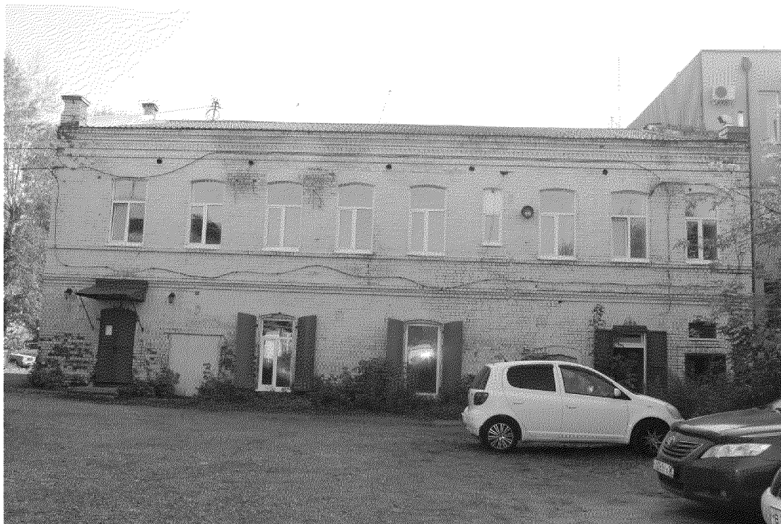
Видовая точка № 10 Западный (дворовый) фасад здания
