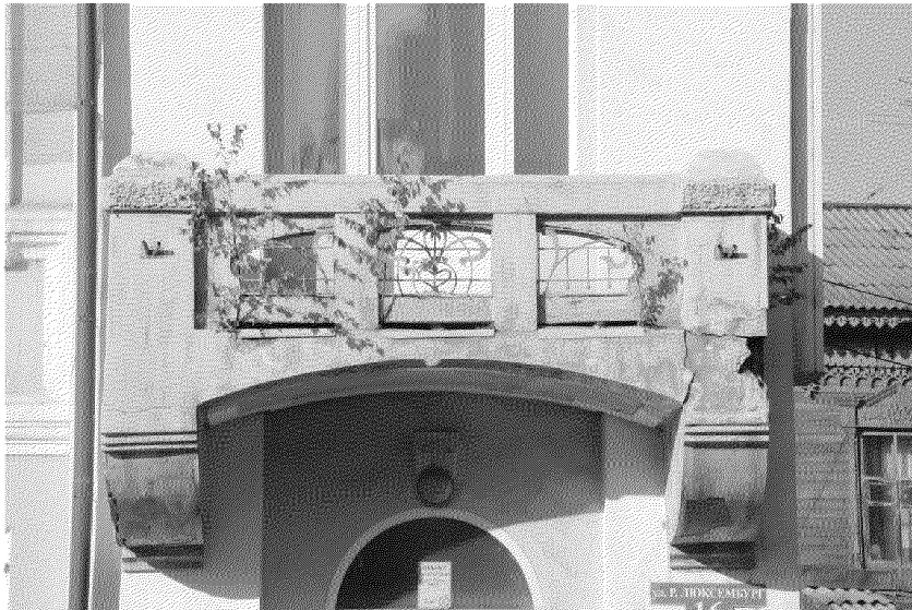
Видовая точка № 7. Фрагмент ризалита главного фасада. Балкон
