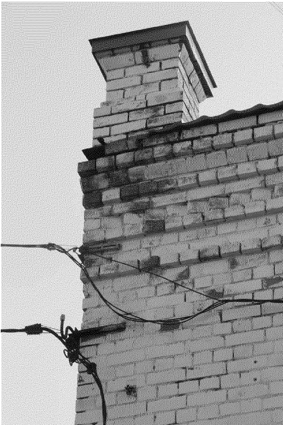
Видовая точка № 14 Кирпичный столбик завершения северного фасада
