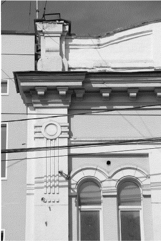
Видовая точка № 3 Фрагмент декора ризалита главного фасада
