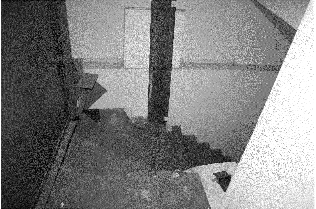
Видовая точка № 20 Одномаршевая с забежными ступенями лестница дворового входа (Артюховский Г.Т., дата съемки: 22.10.2015)
