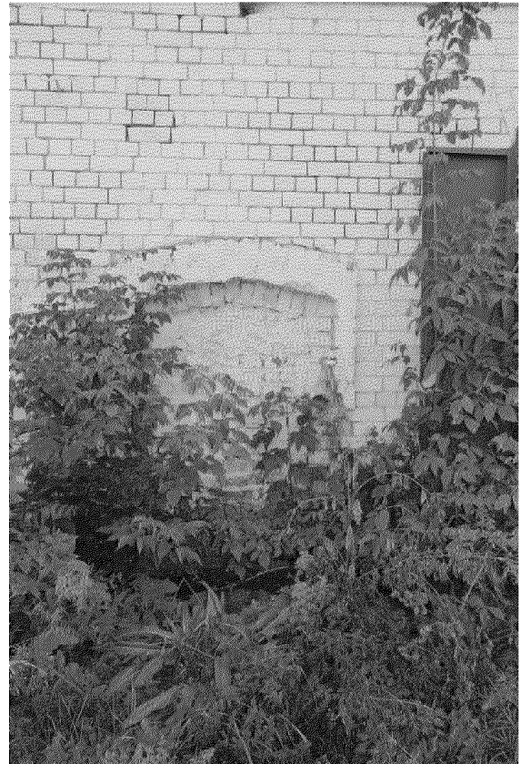
Видовая точка № 15 Лучковый проем с коваными подставами (заложен)
