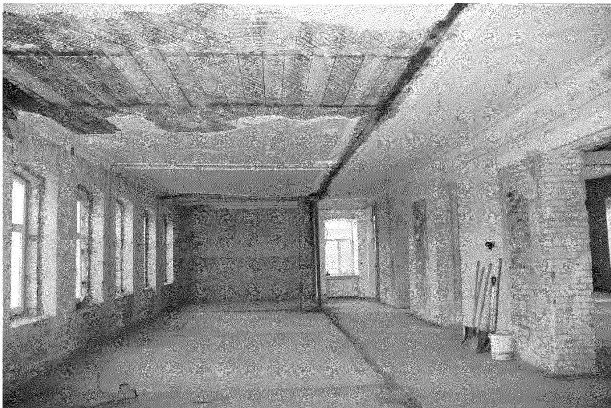
Видовая точка № 22 Общий вид помещения 2-го этажа (Яблонская М.А., 27.09.2019)
