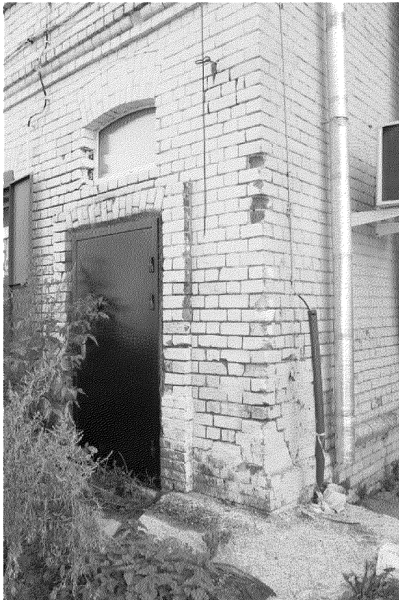
Видовая точка № 16 Фрагмент западного фасада. Дворовый вход
