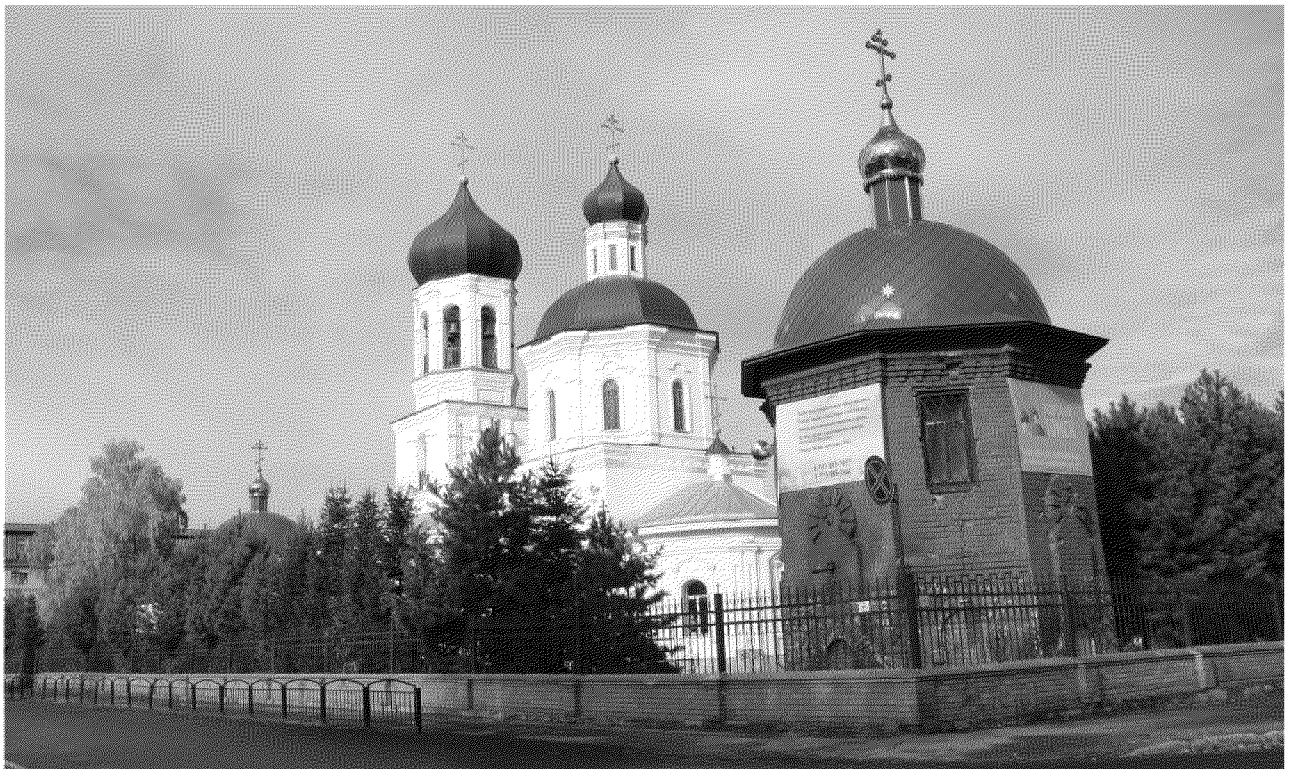
Видовая точка № 4. Водоразборная будка (1904 г.), расположенная по адресу: Войкова улица, 16 строение 2 (Яблонская М.А., 2018 г.)
