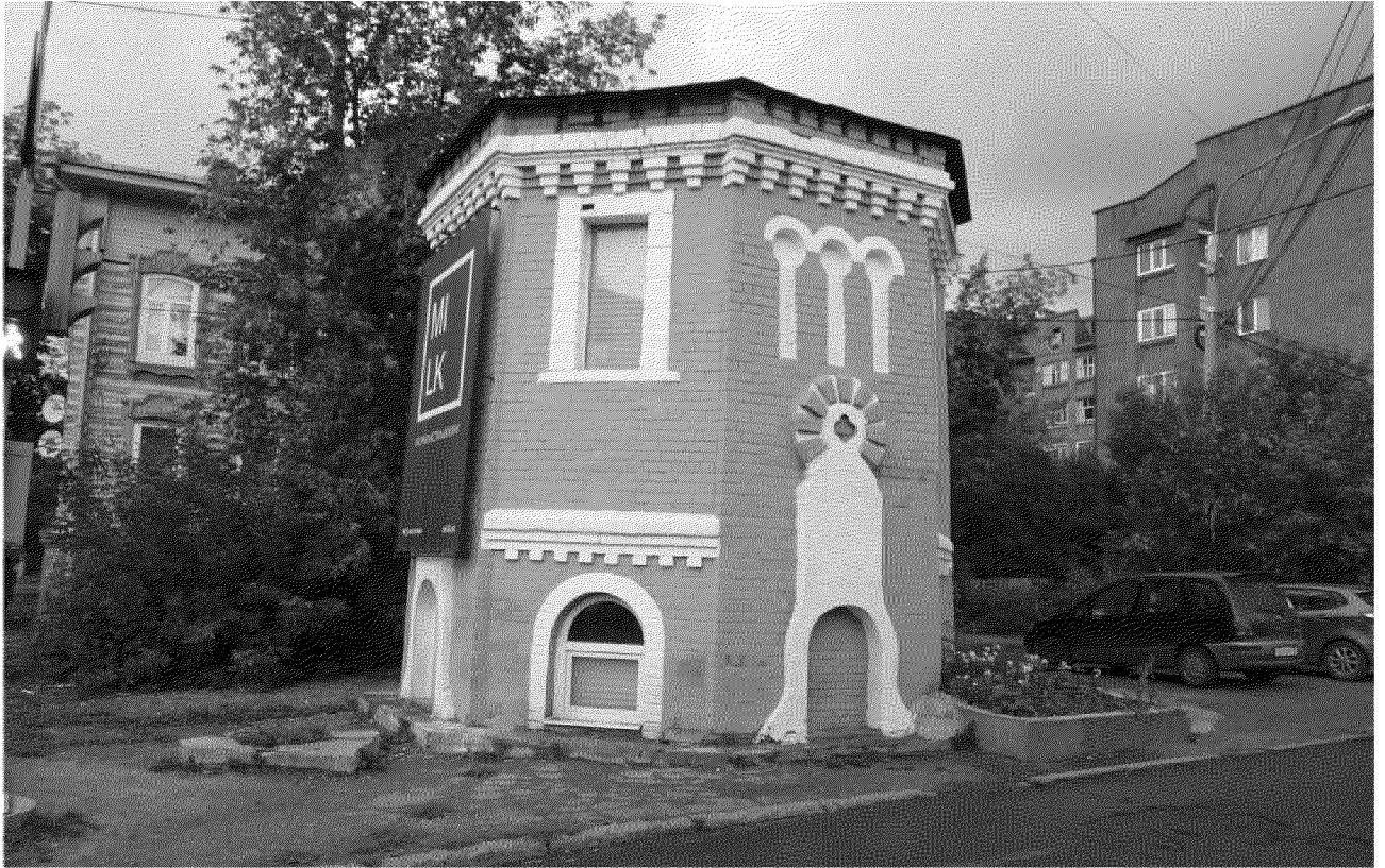
Видовая точка № 7. Водоразборная будка (1904 г.), расположенная по адресу: Розы Люксембург улица, 67а (Олейник А.Ю., 2019 г.)
