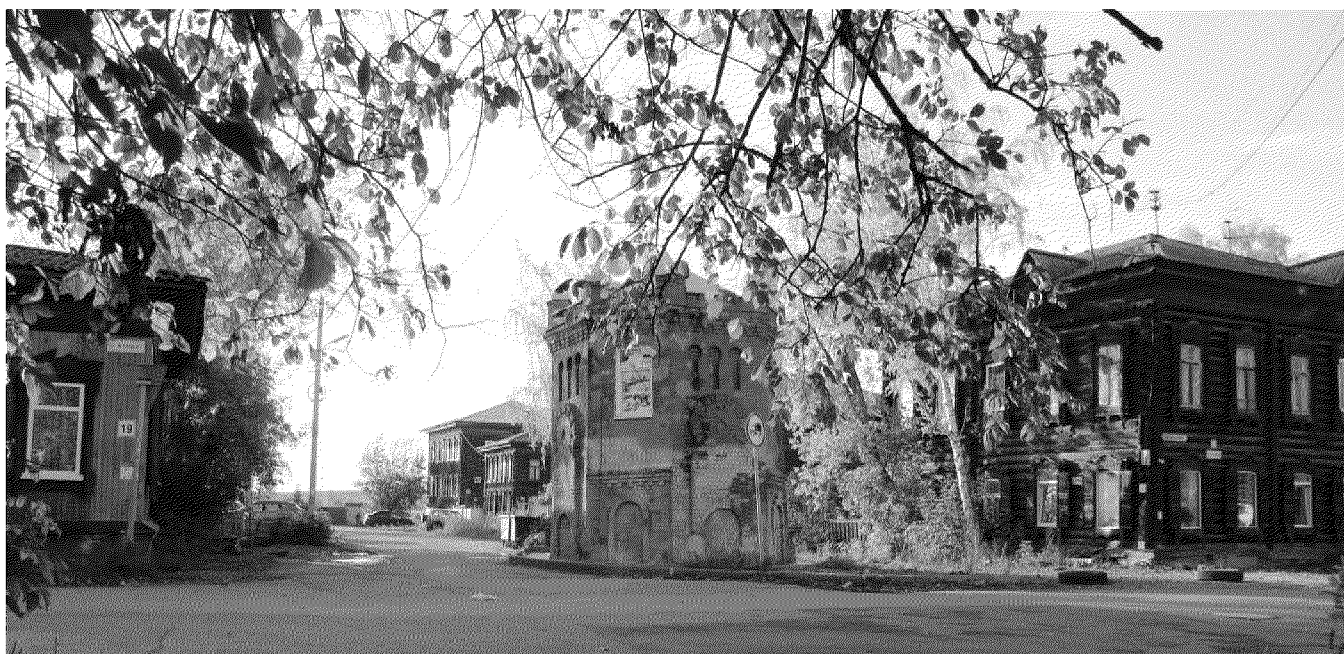
Видовая точка №2. Общий вид застройки с ул. Максима Горького.
