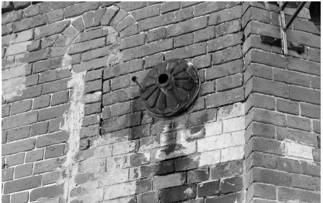
Видовая точка № 10. Металлический накладной элемент, фиксирующий выход водопроводной трубы (северо-западный фасад)
