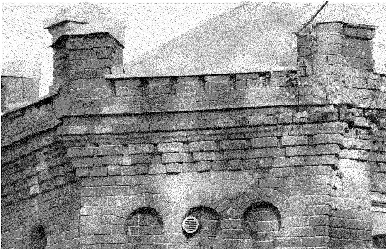
Видовая точка №5. Фрагмент карниза. Парапетное ограждение
