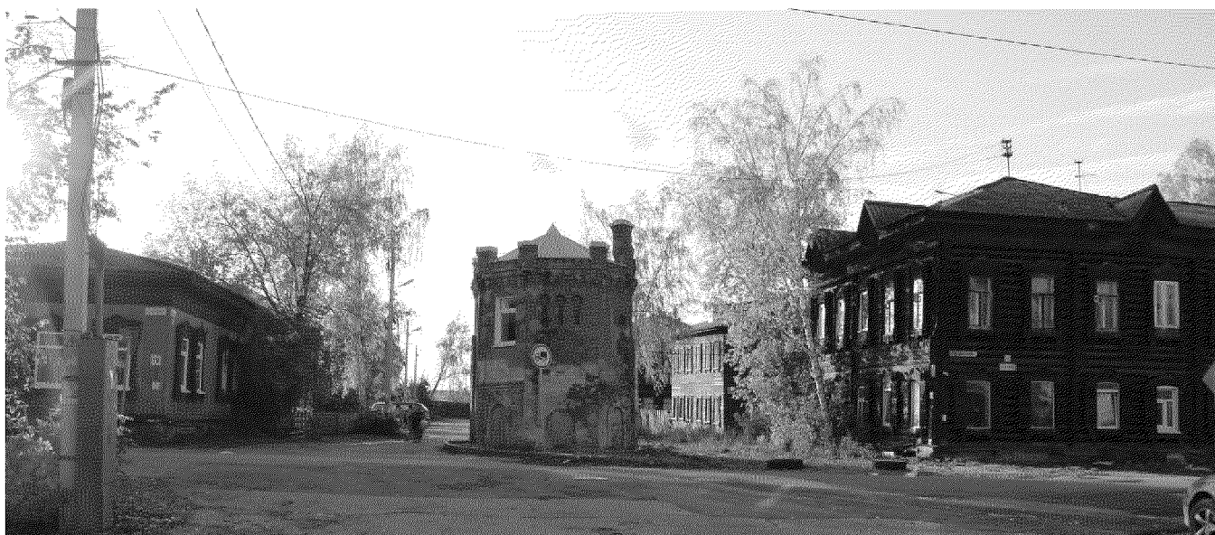
Видовая точка №1. Общий вид застройки с ул. Максима Горького
