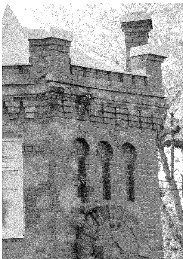
Видовая точка № 8. Фрагмент северного фасада, фигурные окна (ниши) 2-го этажа
