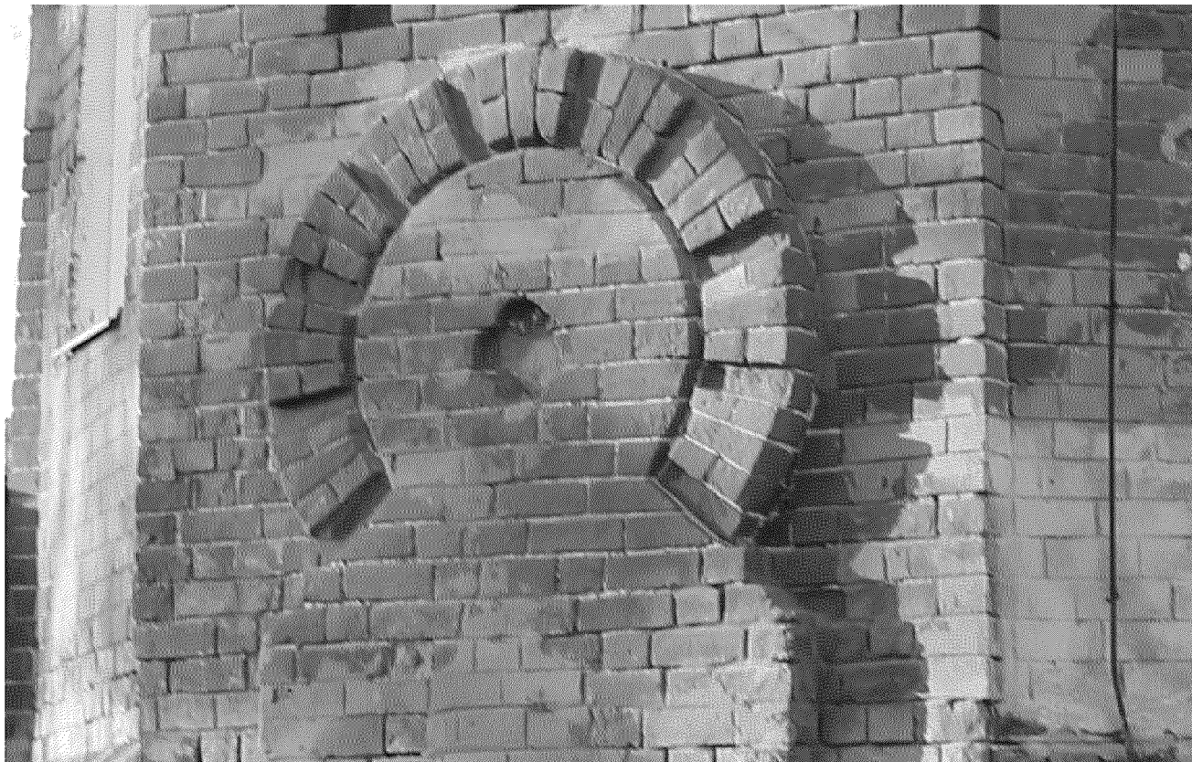
Видовая точка № 6. Фрагмент декоративного элемента северного фасада сооружения
