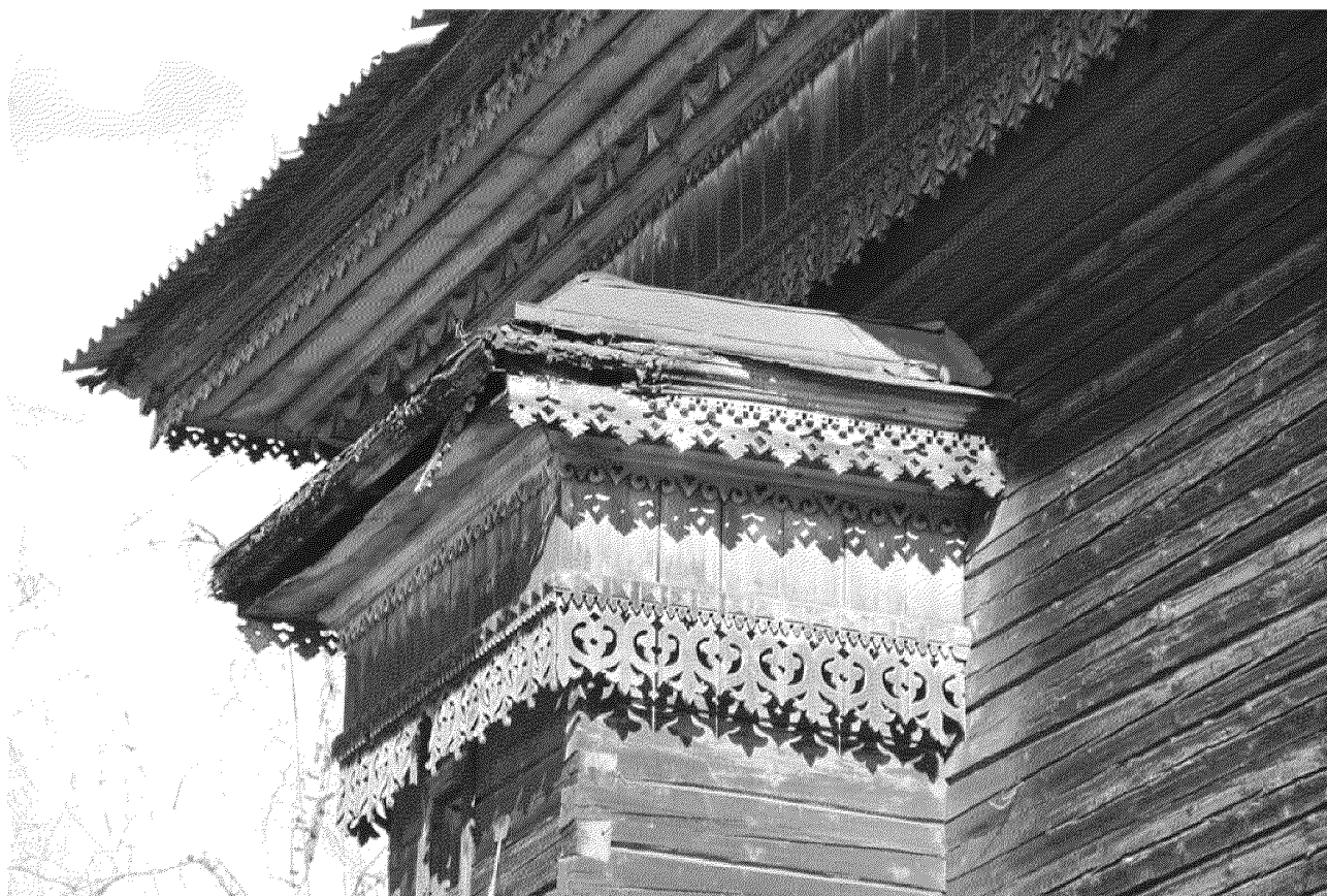
Видовая точка № 10. Карниз прируба, элементы резного декора (Лырова Е., 27.04.2018).
