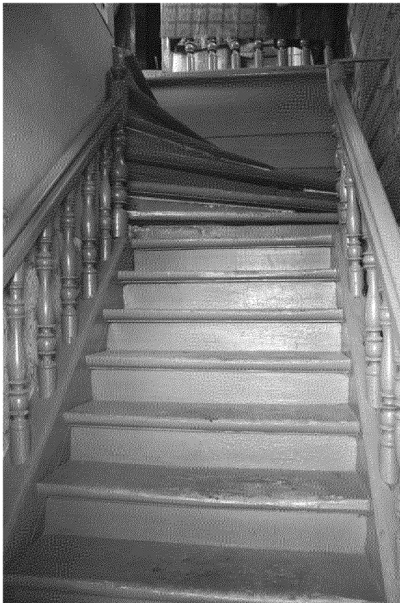
Видовая точка № 15. Г-образная лестница с забежными ступенями и ограждением из балясин (автор снимка: Яблонская М.)
