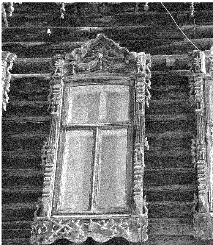
Видовая точка № 7. Лучковое окно 1-го этажа дворового фасада с наличником (автор снимка: Яблонская М.А.)
