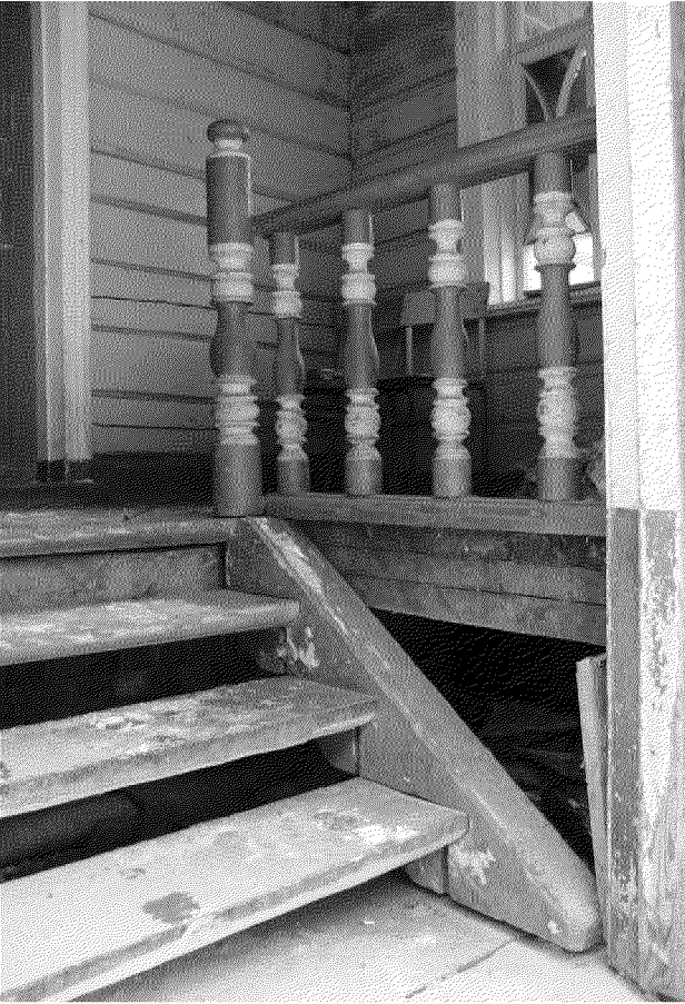
Видовая точка № 16. Крыльцо западного фасада (в тамбуре) с ограждением из балясин, 2014 г.
