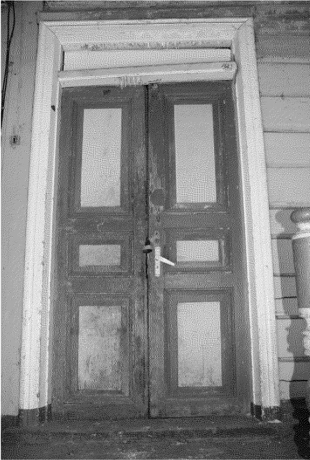
Видовая точка № 20. Квартира западной части дома. Входная дверь (дата снимка: 2014)
