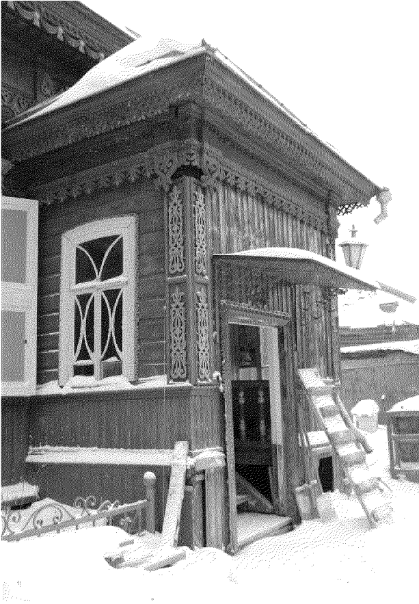
Видовая точка № 12. Тамбур входа западного фасада (2014 г.).
