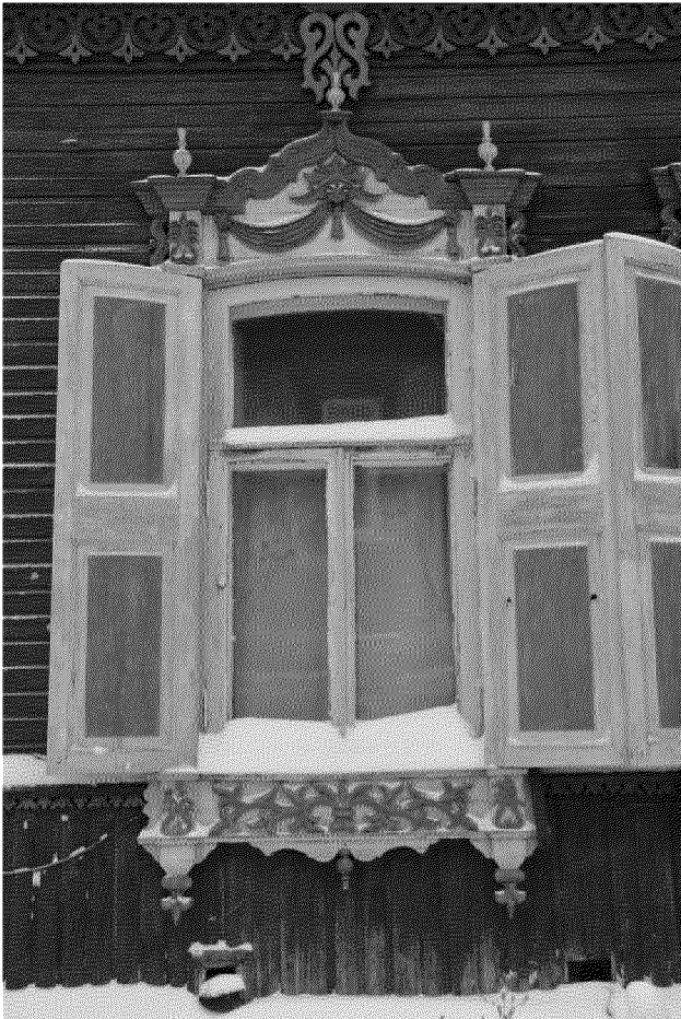
Видовая точка № 14. Окно западного фасада со ставнями (дата снимка: 2014 г.)
