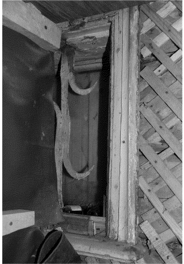
Видовая точка № 21. Кованая решетка окна дворовой пристройки (дата снимка: 2014)
