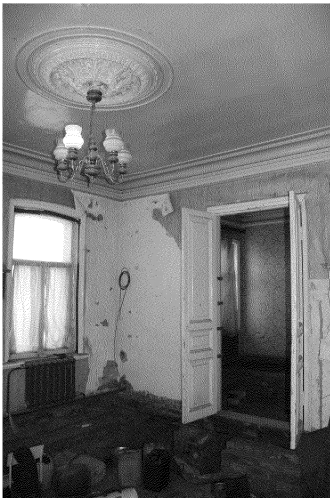
Видовая точка № 29. Угловая комната квартиры западной части дома (дата снимка: 2014)
