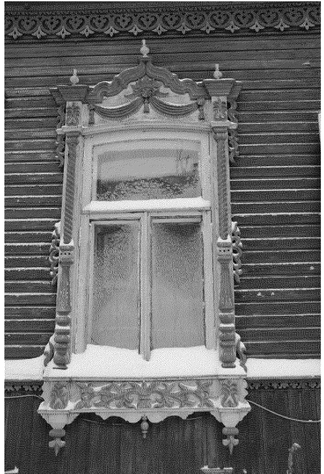
Видовая точка № 15. Окно западного фасада (дата снимка: 2014 г.)
