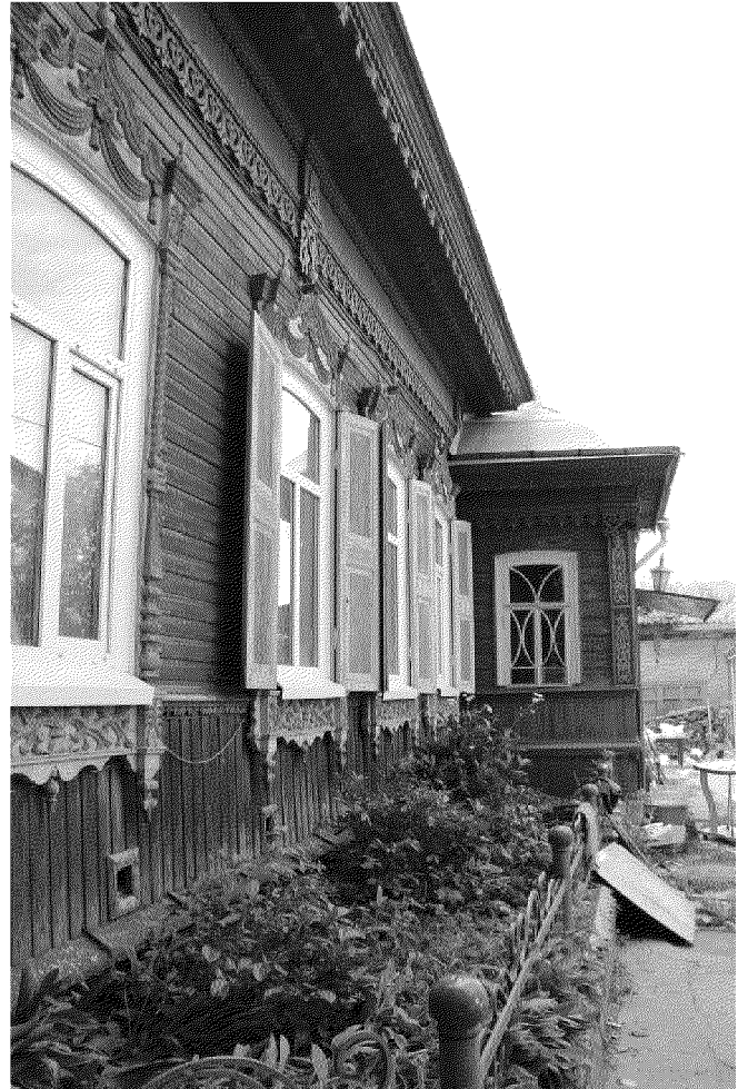
Видовая точка № 8. Боковой (западный) фасад
