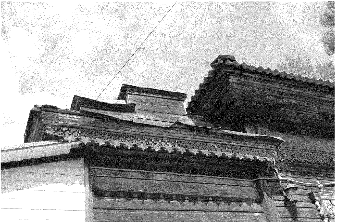
Видовая точка № 9. Фрагмент восточного фасада. Ступенчатый аттик пристройки
