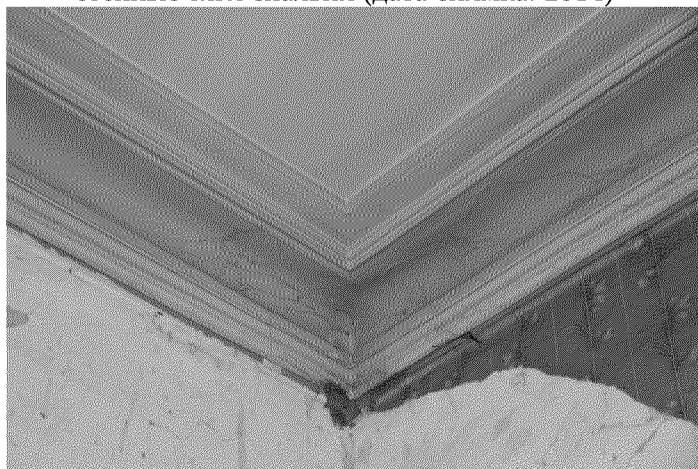
Видовая точка № 31. Профильные потолочно-стенные тяги углового зального помещения (дата снимка: 2014)
