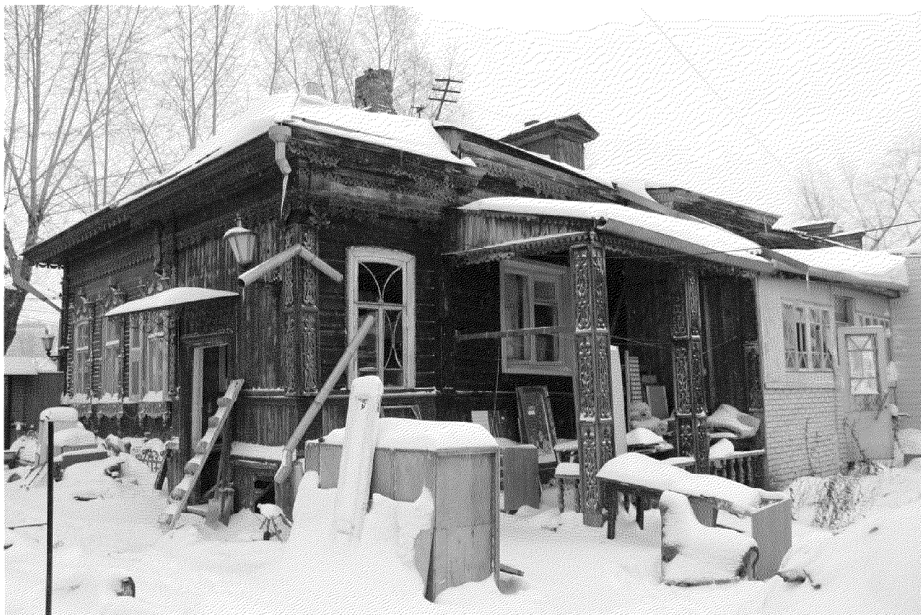
Видовая точка № 10. Общий вид здания с юго-западной стороны (дата снимка: 2014 г.)
