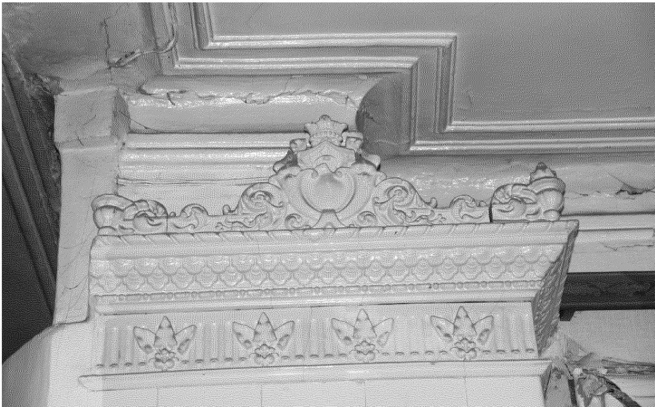
Видовая точка № 27. Карниз изразцовой печи (дата снимка: 2014)
