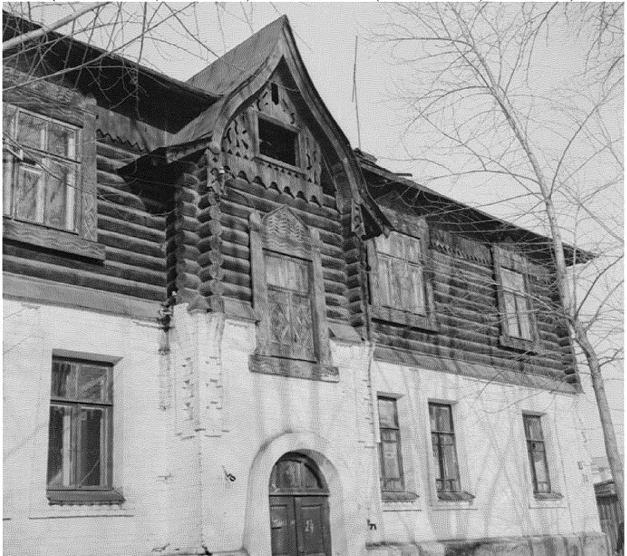
Видовая точка № 30. Восточный фасад. Историческая расстеловка заполнения оконных проемов (фото: П.Н. Коханенко, 1968-1974 гг.)
