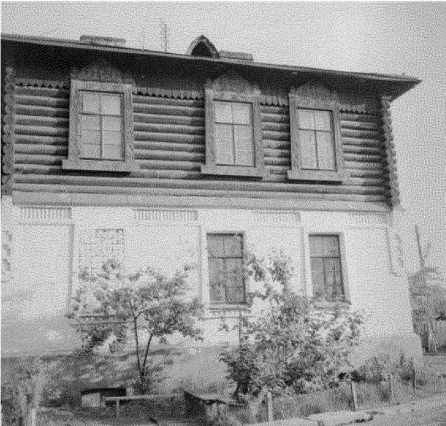
Видовая точка № 28. Северный фасад (П.Н. Коханенко, 1968-1974 гг.)
