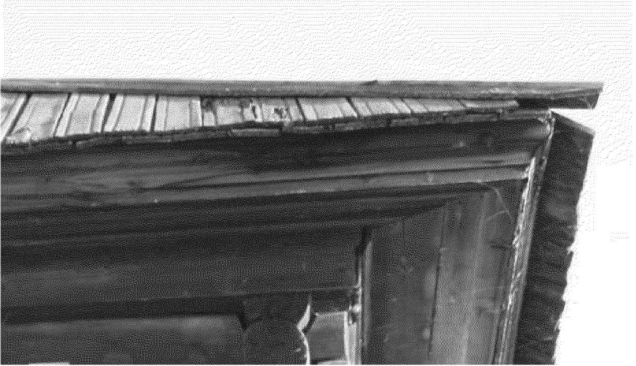
Видовая точка № 5. Фрагмент карниза основного объёма здания
