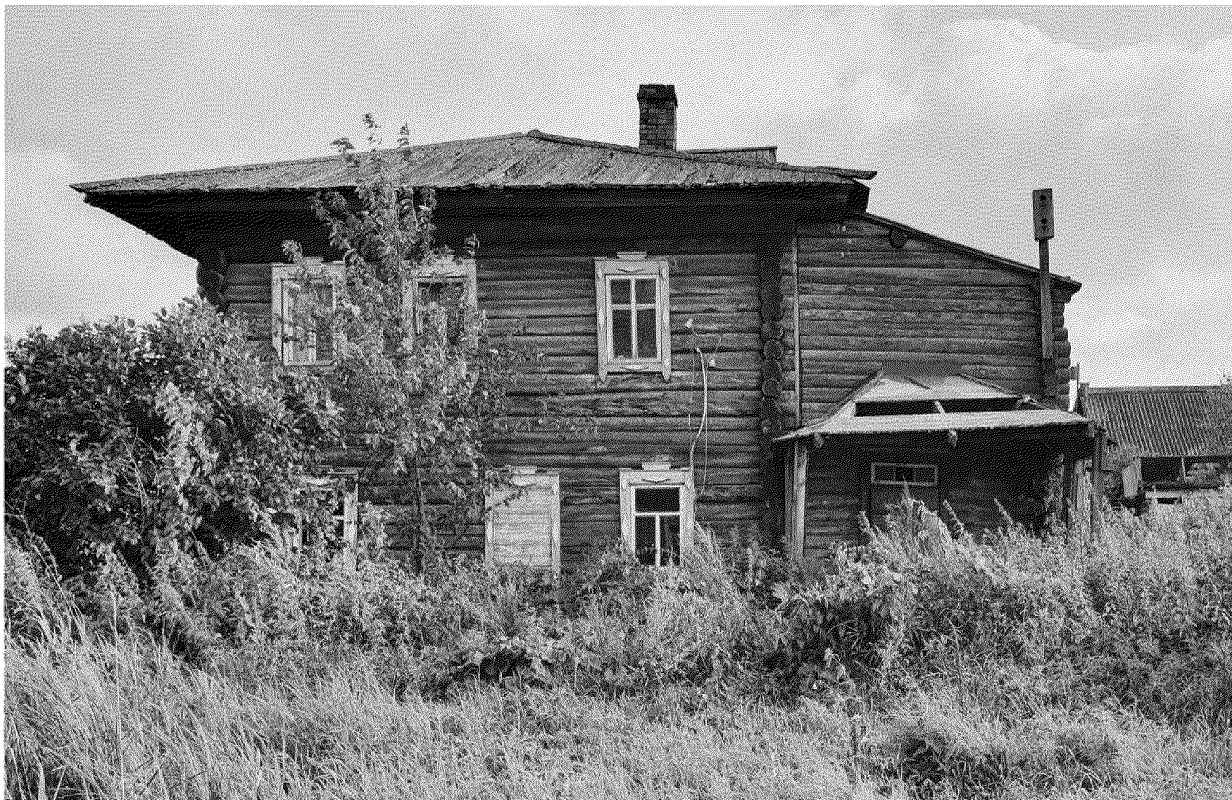
Видовая точка № 3. Северный фасад здания, вид с территории двора (Проскоков С.В., 27.08.2022)
