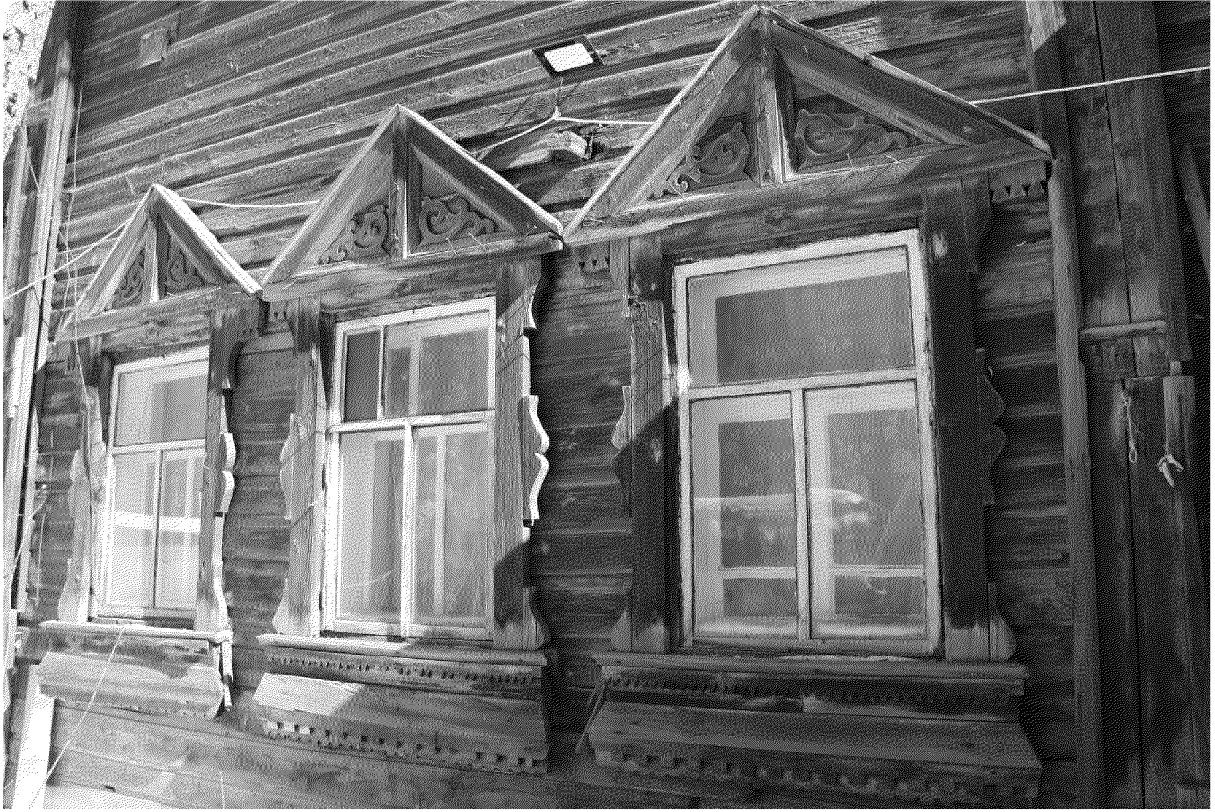
Видовая точка № 14 Фрагмент западного фасада, окна первого этажа с наличниками
