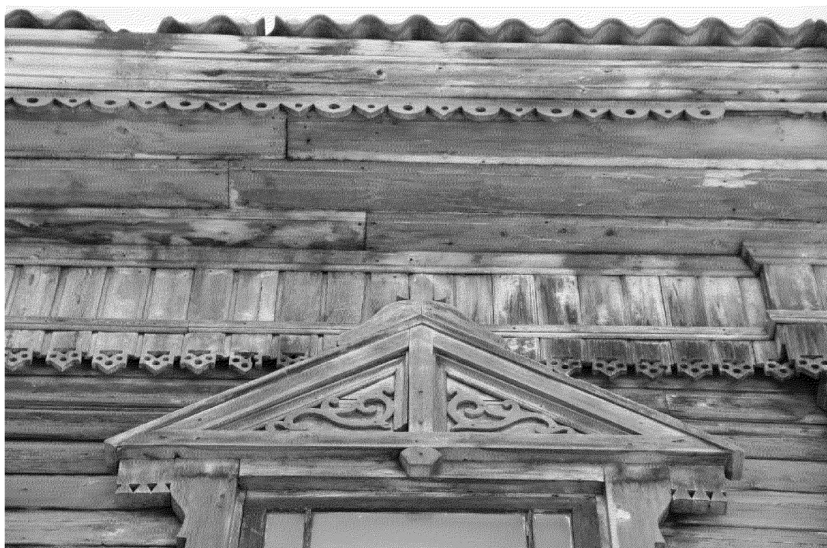
Видовая точка № 13 Фрагмент карниза и наличника окна 2-го этажа северного фасада
