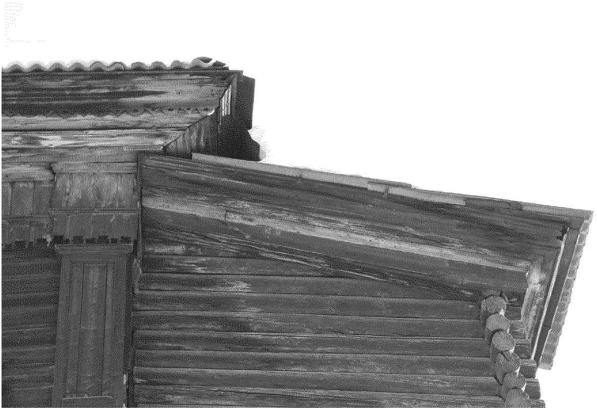
Видовая точка № 15 Фрагмент западного фасада, карниз пристройки
