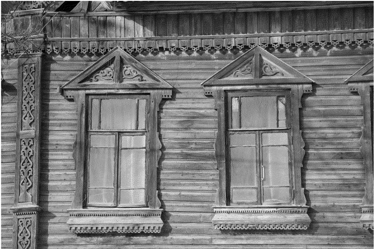
Видовая точка № 4. Фрагмент главного фасада, окна 2-го этажа с наличниками
