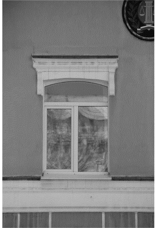
Видовая точка № 4. Оконный лучковый проем 2-го этажа. Северный фасад.
