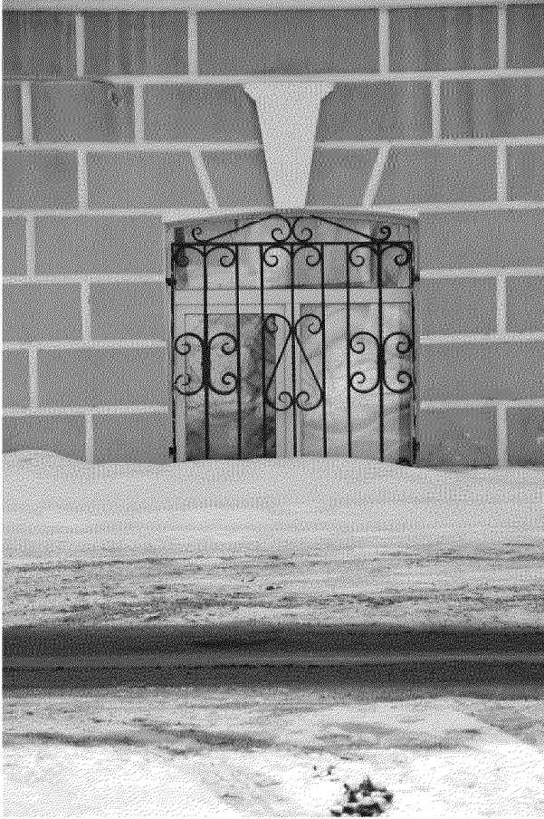
Видовая точка № 3. Оконный лучковый проем 1-го этажа. Северный фасад.
