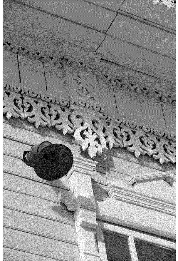
Видовая точка № 4. Фрагмент южного фасада
