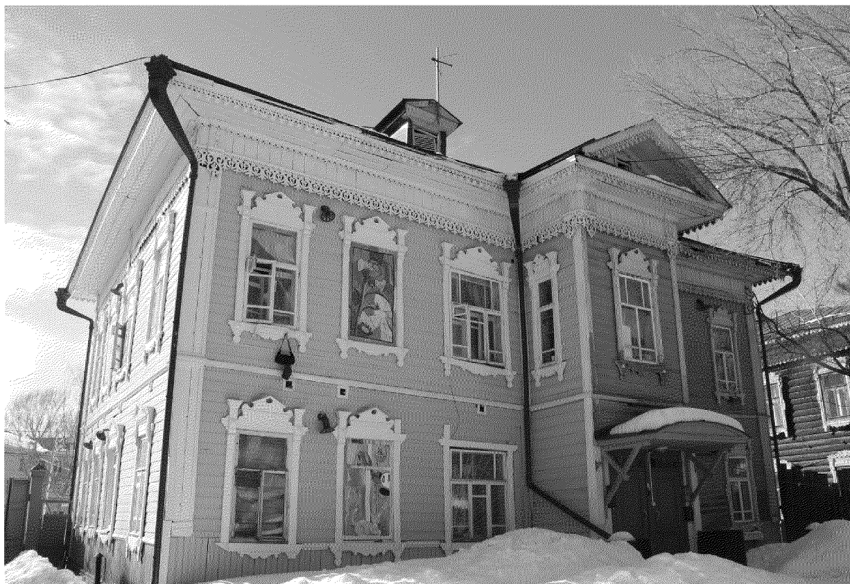
Видовая точка № 6. Восточный фасад здания, вид с территории двора
