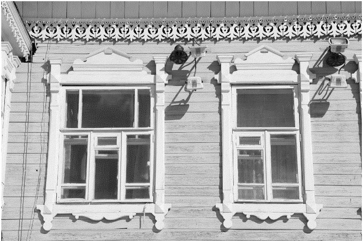
Видовая точка № 5. Окна второго этажа главного западного фасада
