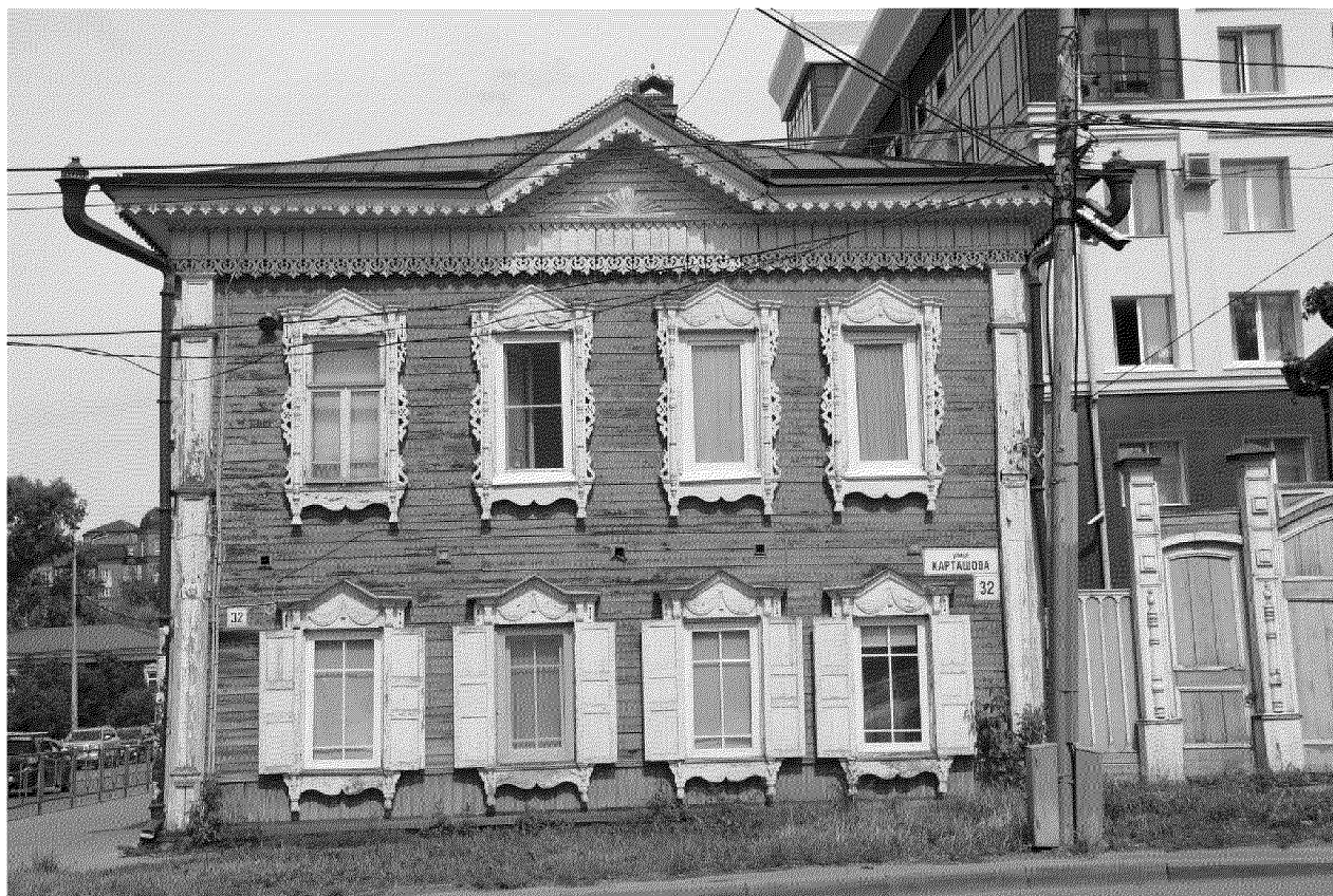
Видовая точка № 3. Южный фасад здания, вид с ул. Карташова (Яблонская М.А., 29.07.2024)
