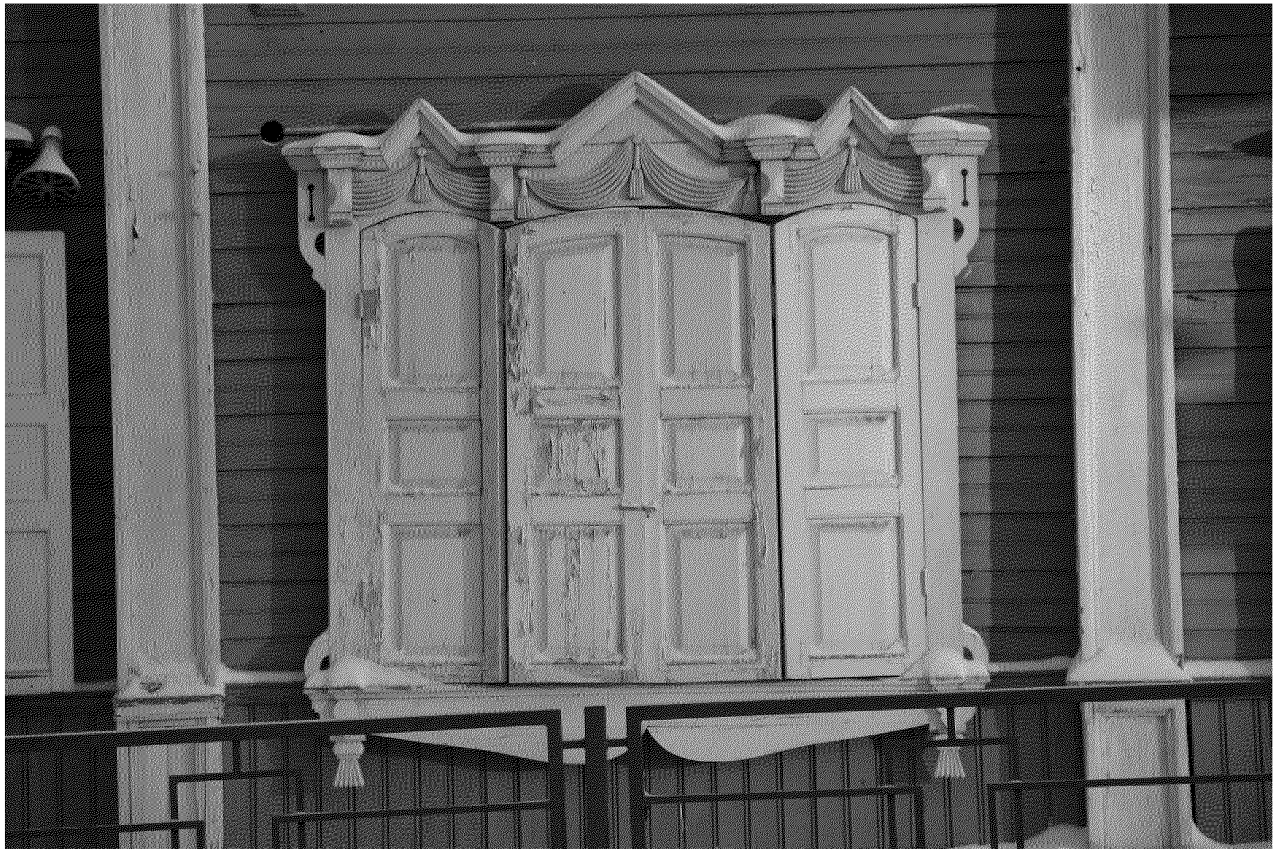
Видовая точка № 9. Трехчастное окно 1-го этажа со ставнями западного фасада (Олейник А.Ю., 2022)
