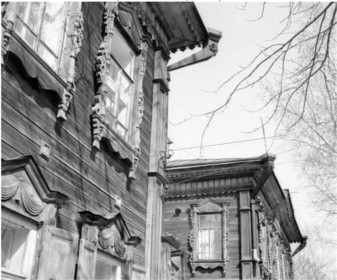
Видовая точка № 14. Исторический вид водосточных труб (Коханенко П.Н., 1968-1974 гг.)
