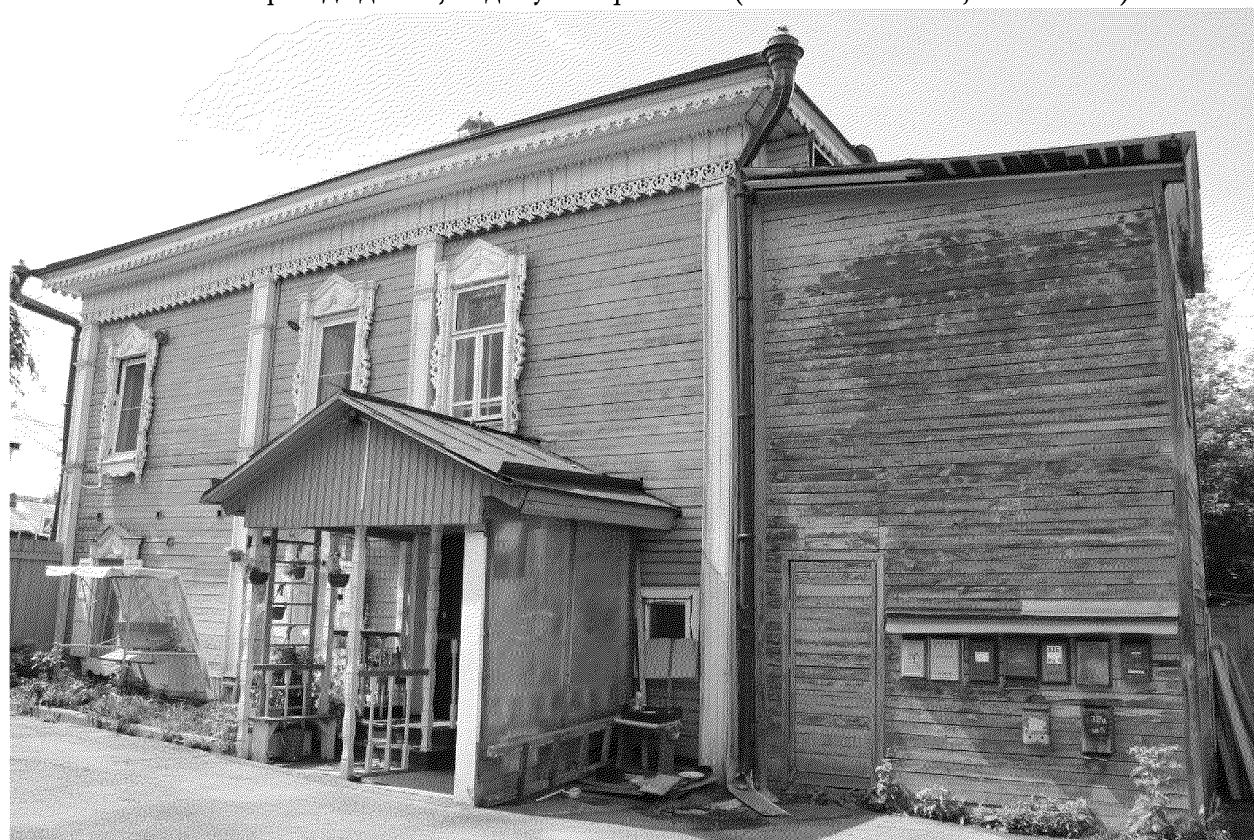
Видовая точка № 4. Восточный фасад здания, вид с территории двора (Яблонская М.А., 29.07.2024)
