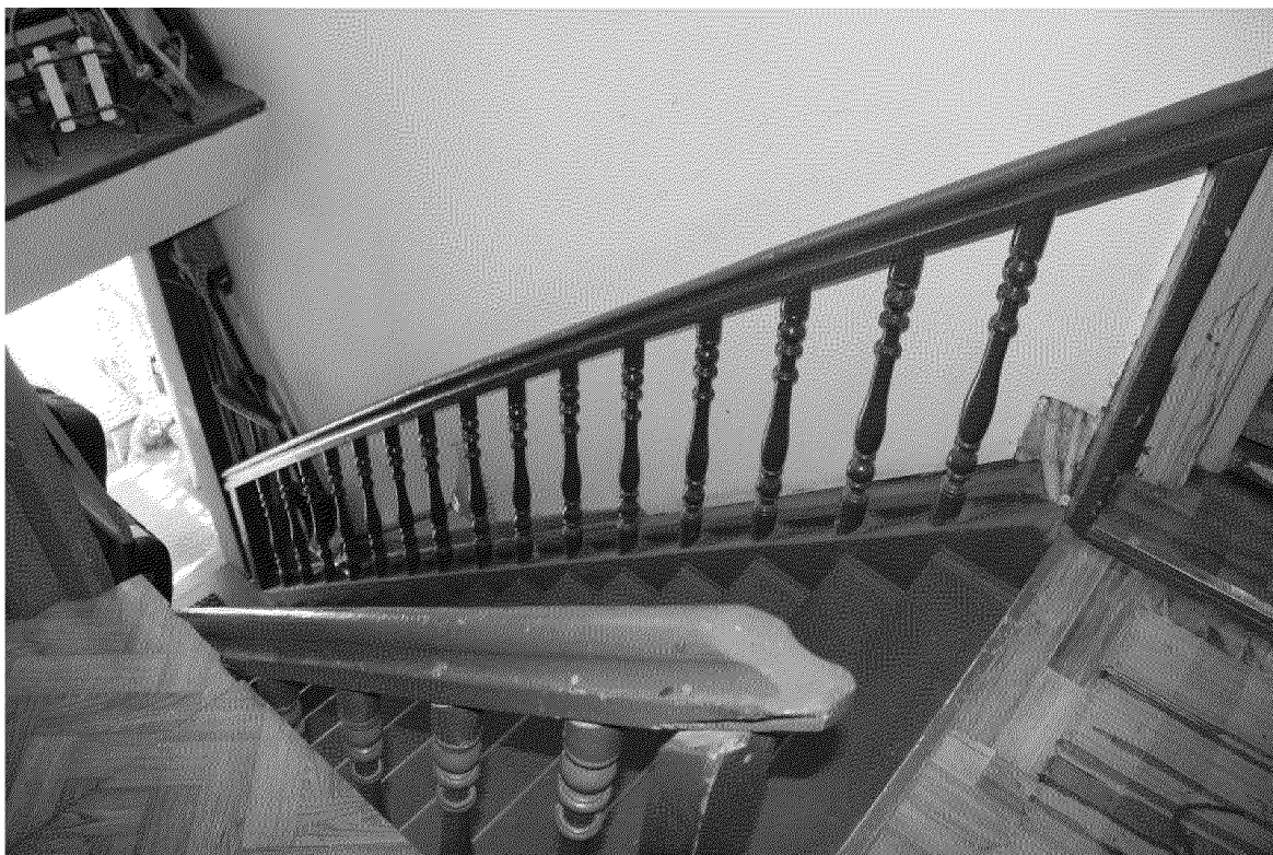
Видовая точка № 12. Деревянная лестница подъема на второй этаж (Яблонская М.А., 29.07.2024)
