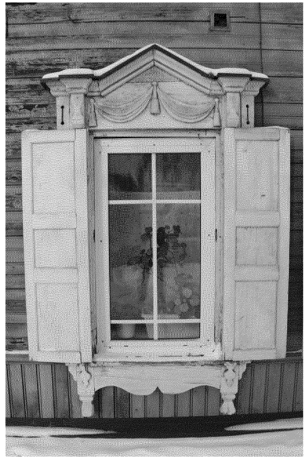
Видовая точка № 7. Окно 1-го этажа западного фасада (Олейник А.Ю., 2022)
