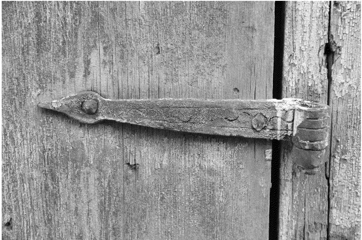
Видовая точка № 10. Кованая скобяная фурнитура ставней окна 1-го этажа западного фасада (Яблонская М.А., 02.08.2024)
