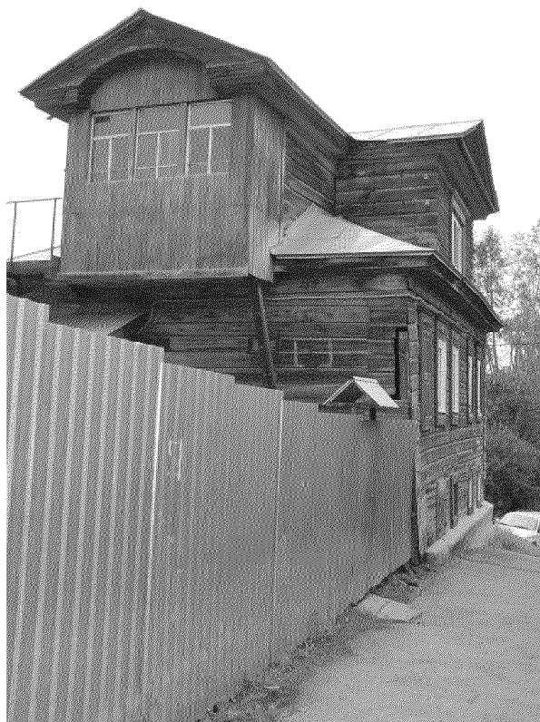
Видовая точка № 5. Северный фасад здания с балконом (Яблонская М.А., 02.08.2024)
