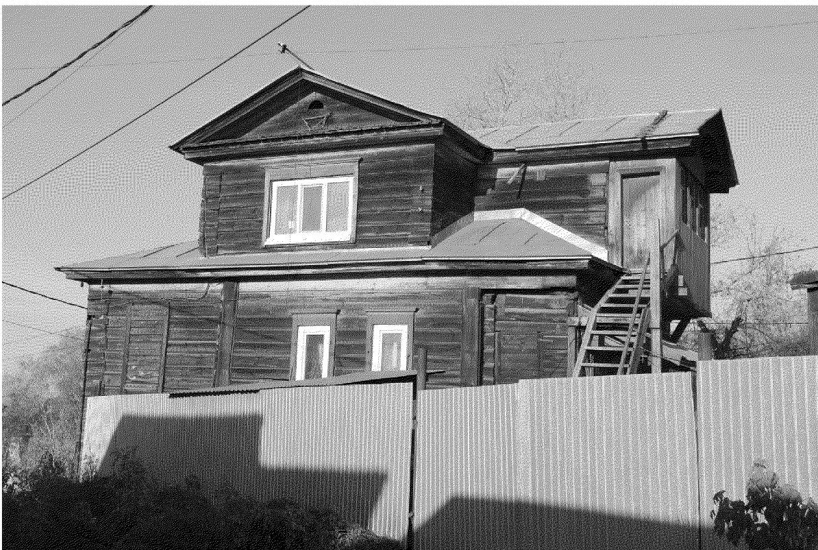
Видовая точка № 4. Восточный фасад здания, вид с пер. Песочного (Верховая К.Е., 13.10.2021)
