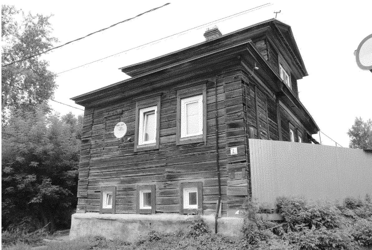
Видовая точка № 3. Южный фасад здания (Яблонская М.А., 02.08.2024)
