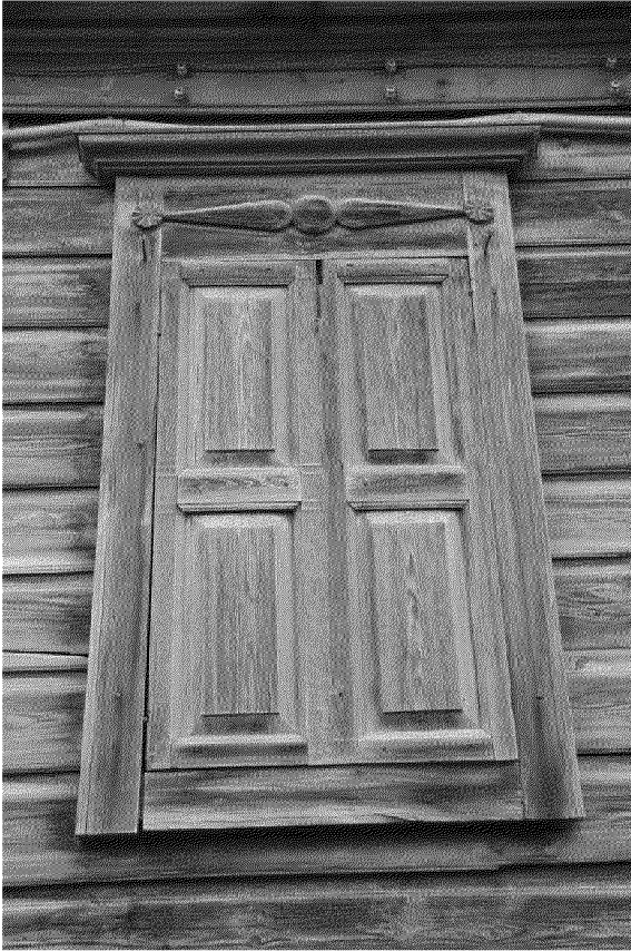
Видовая точка № 8. Наличник 2-го этажа западного фасада со ставнями (Яблонская М.А., 02.08.2024)
