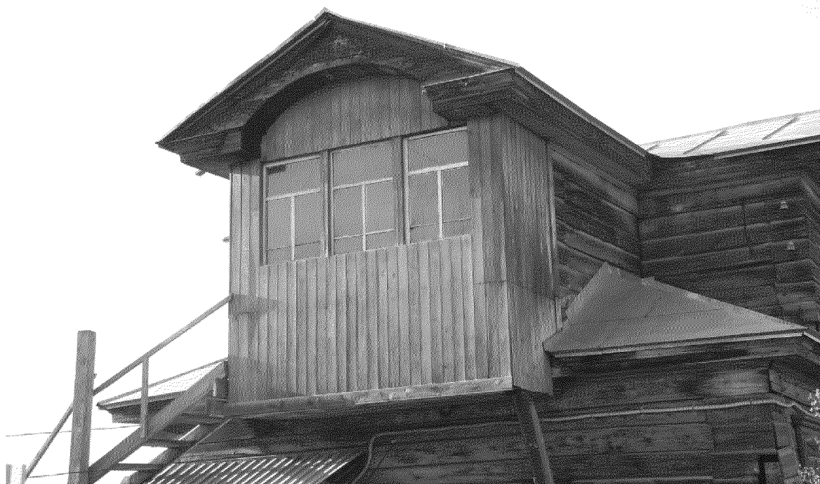
Видовая точка № 7. Балкон мезонина северного фасада (Верховая К.Е., 13.10.2021)
