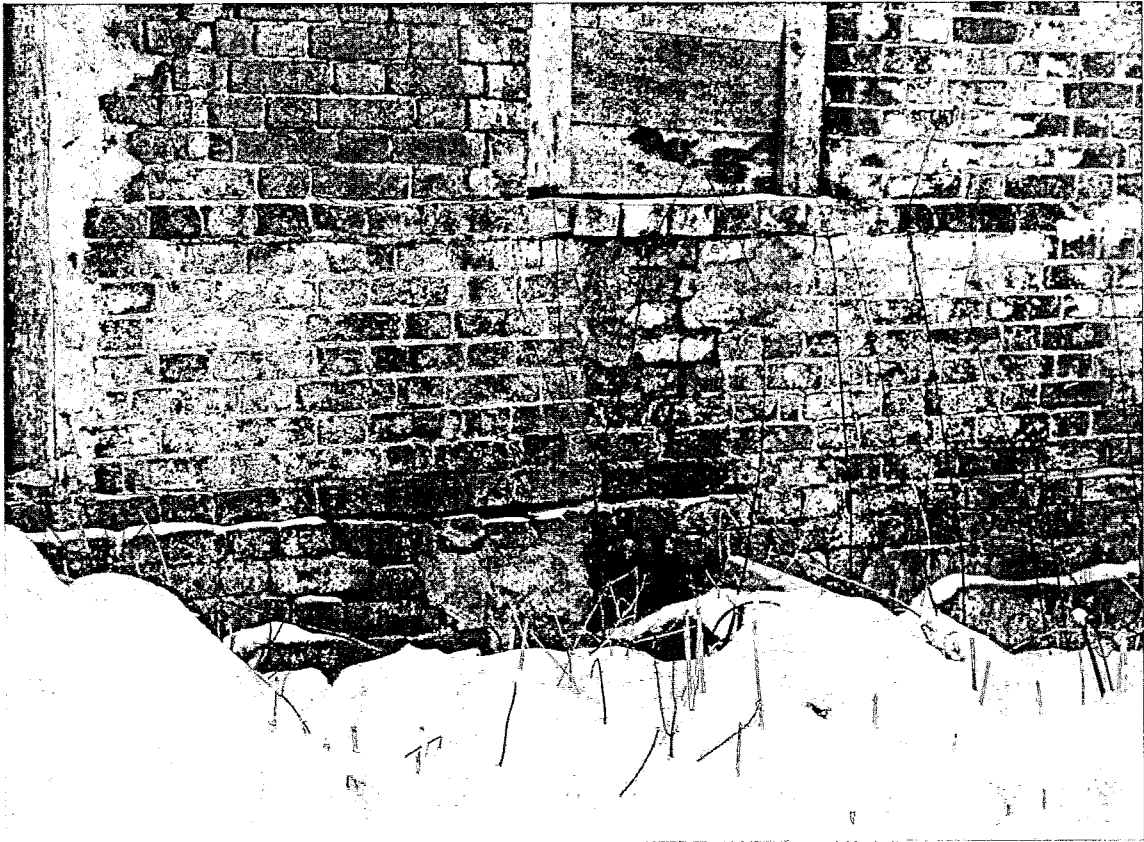
Фото 4. Фрагмент западного фасада
