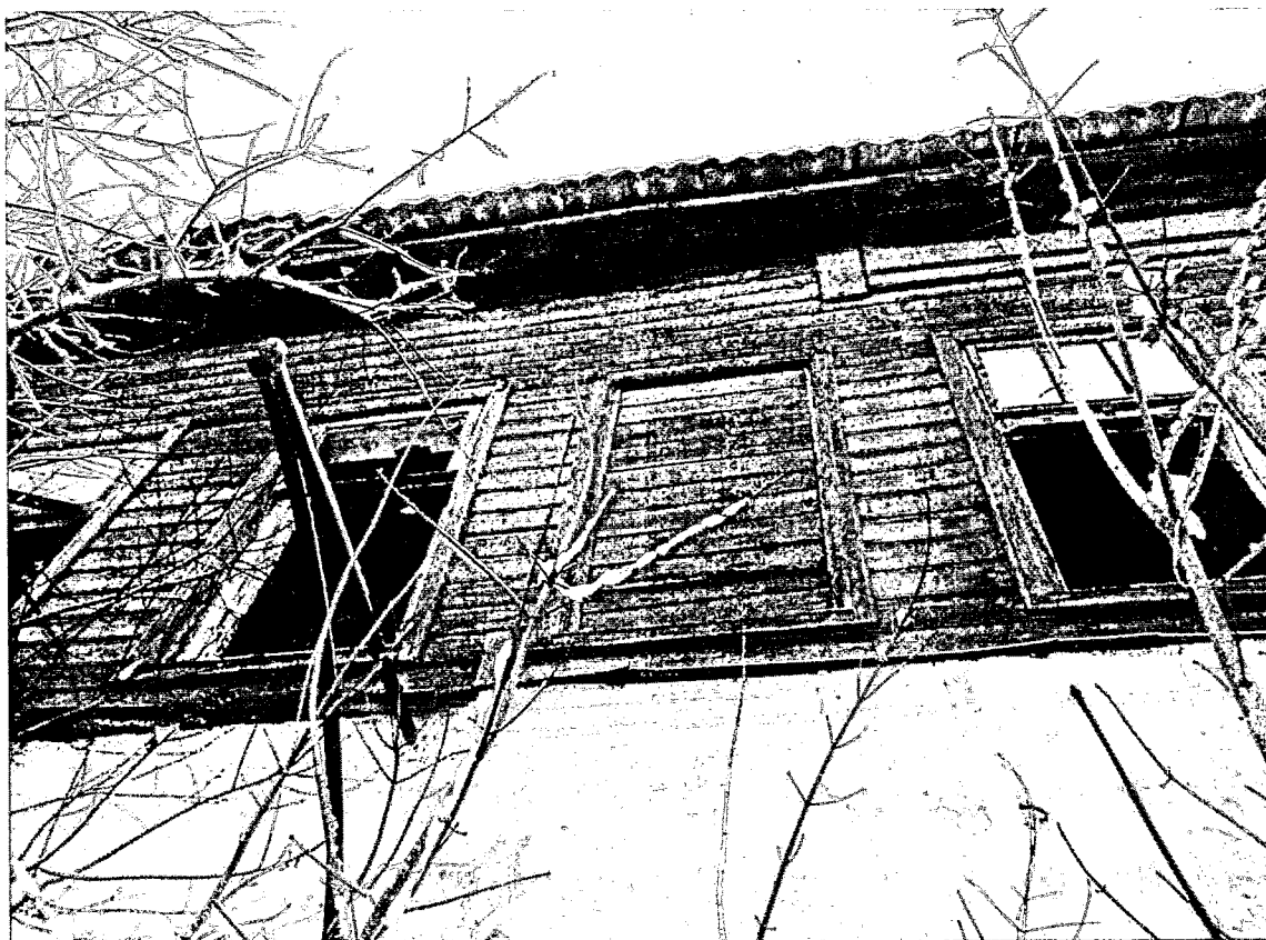
Фото 10. Фрагмент южного фасада
