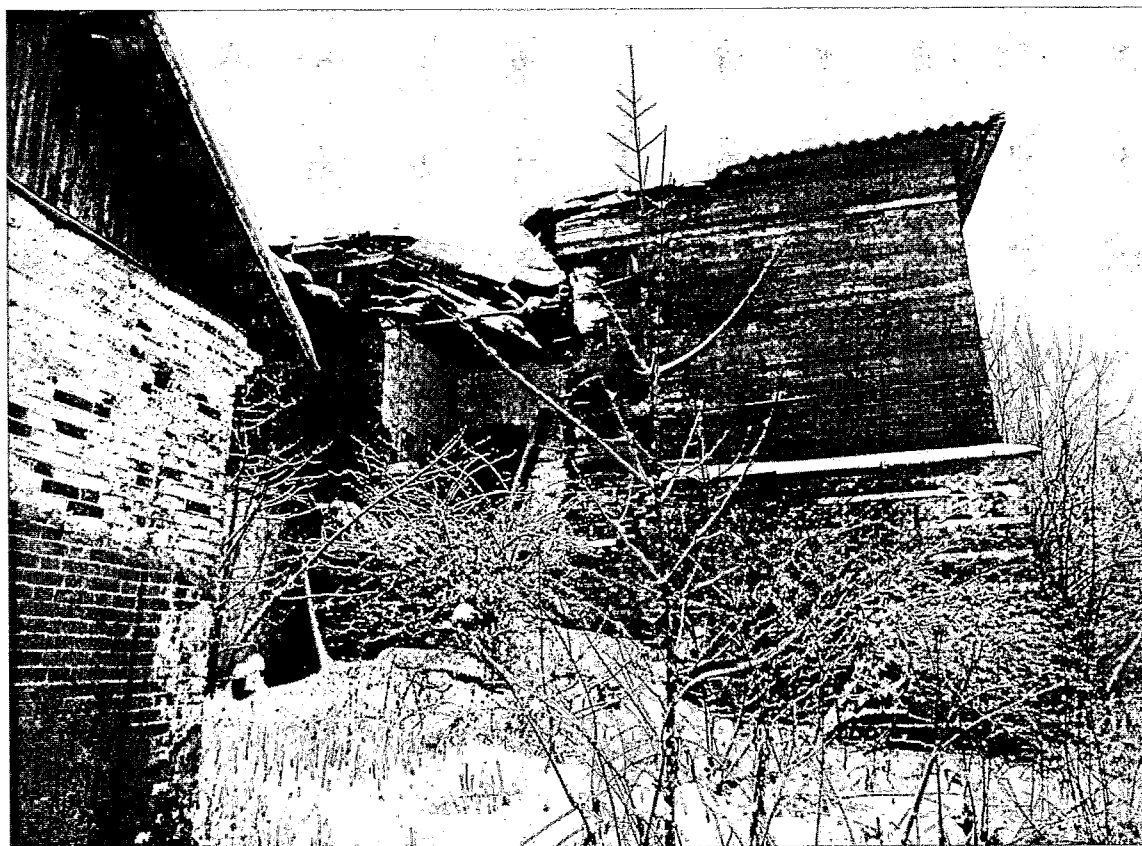
Фото 8. Фрагмент западного фасада
