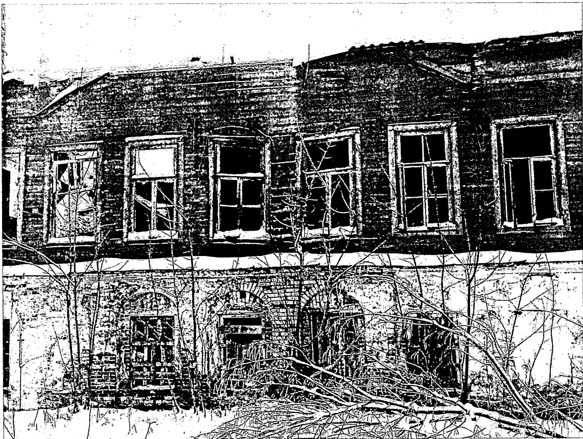
Фото 4. Фрагмент северного фасада
