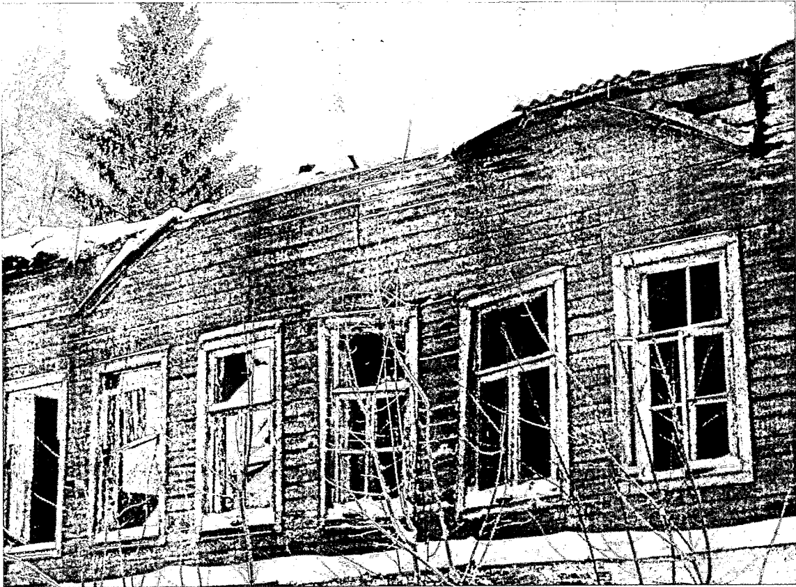
Фото 12. Фрагмент северного фасада
