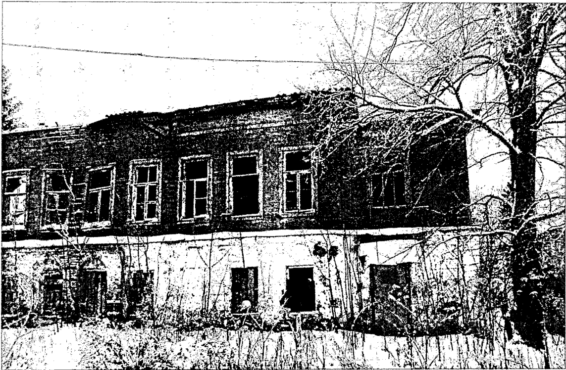
Фото 3. Фрагмент северного фасада
