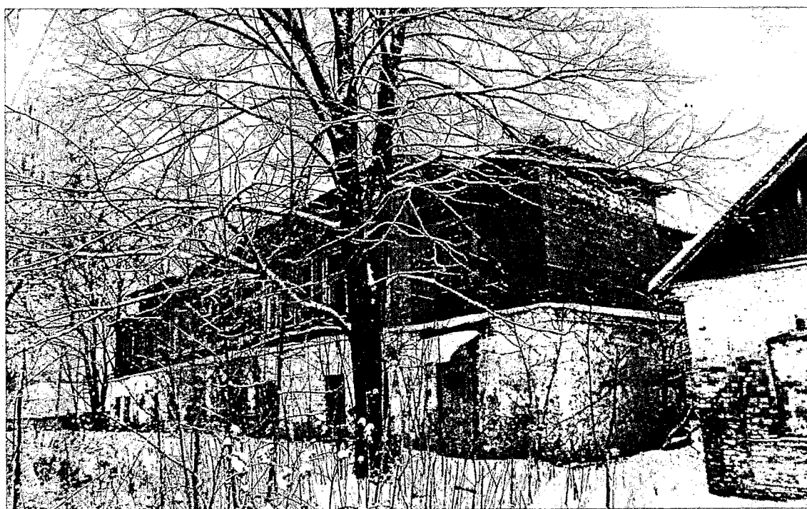
Фото 2. Вид с северо-запада -
