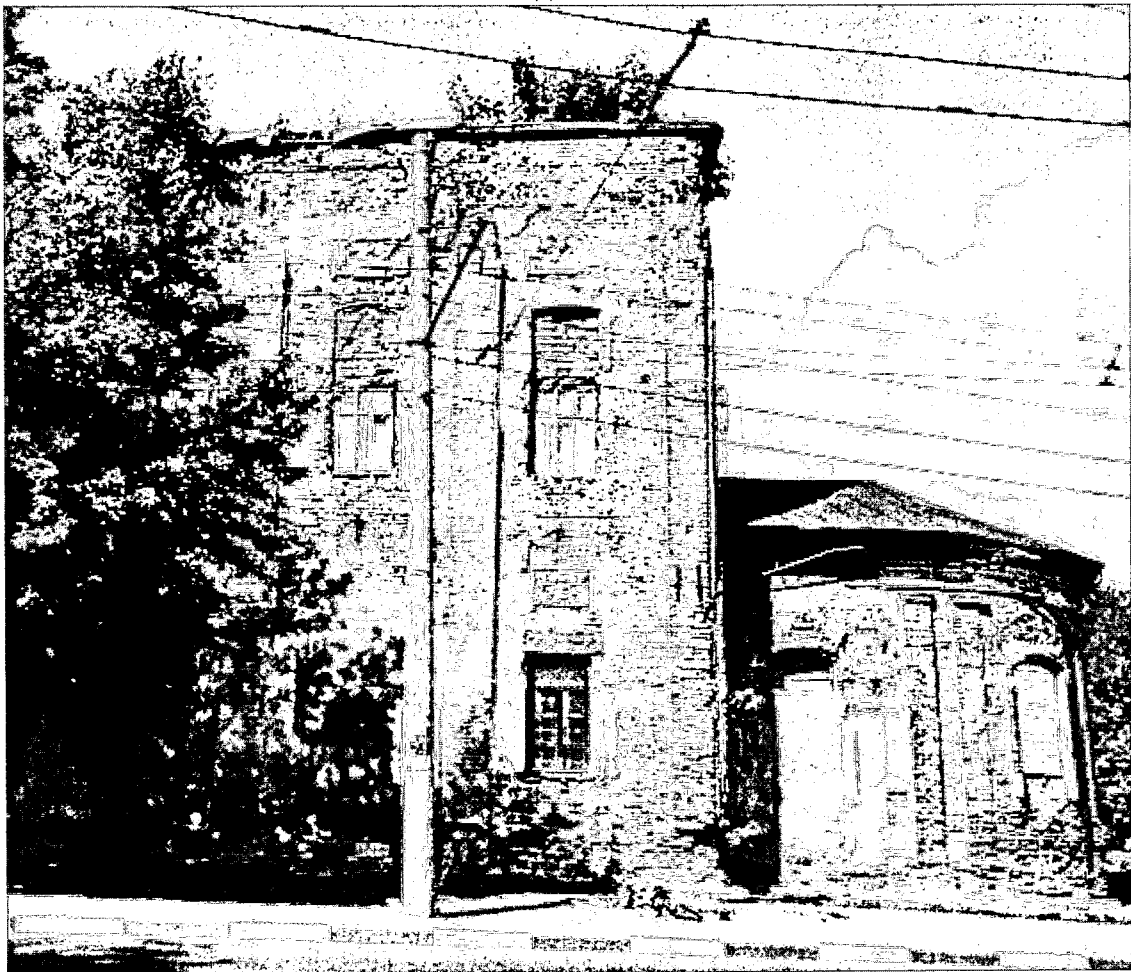
Фото 4. Фрагмент южного фасада
