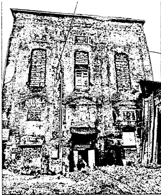
Фото 9. Фрагмент северного фасада
